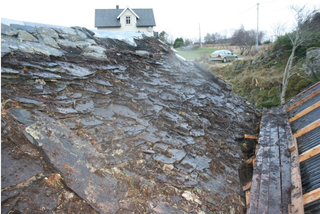
Det meste av tekkingshellene er lagt liggande slik at dei er breiare enn høge, dette kanskje i motsetning til mange villskifertak?
