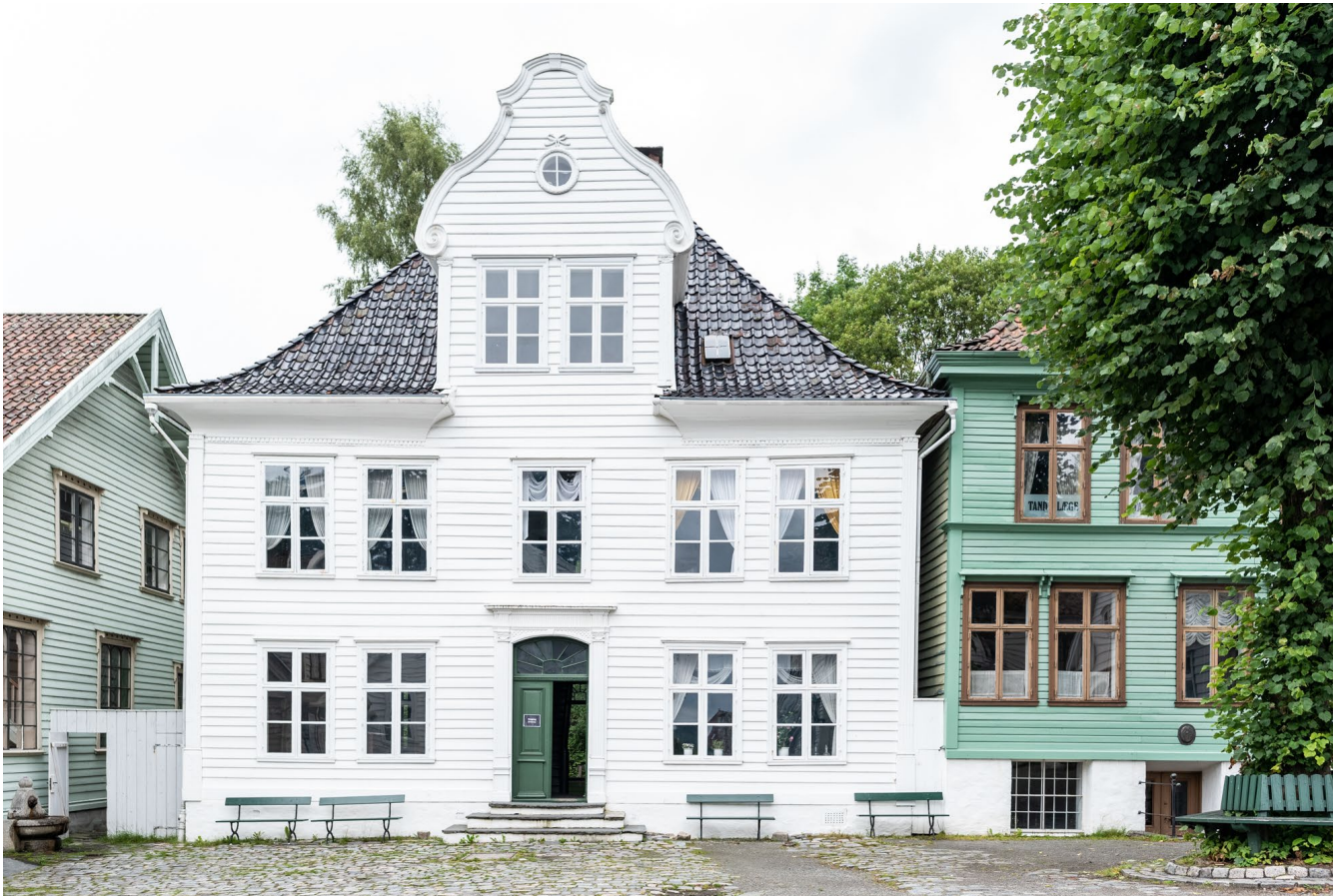
Embetsmannshuset i Gamle Bergen, opprinnelig Kong Oscars gate 48. Foto: Bymuseet i Bergen.
