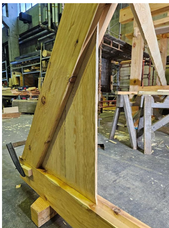
Bilde 53 Veggtiler ferdig tilpasset ned i tilesporet i bindebjelken, og inn i sperra. Tilpasningen gjøres ved å hogge en fals til veggtila passer ned i tilesporet.
