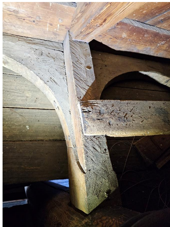
Bilde 39 Typisk eksempel på hvilke deler av emnene som blir høvlet. Synlige flater blir høvlet, oversiden som ikke synes blir ikke høvlet. Bildet er av en strebebjelke i Urnes.
