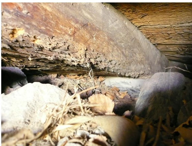
Bilde 21 Slepemerker på en av grunnstokkene i Borgund. Foto Hans Marumrud
