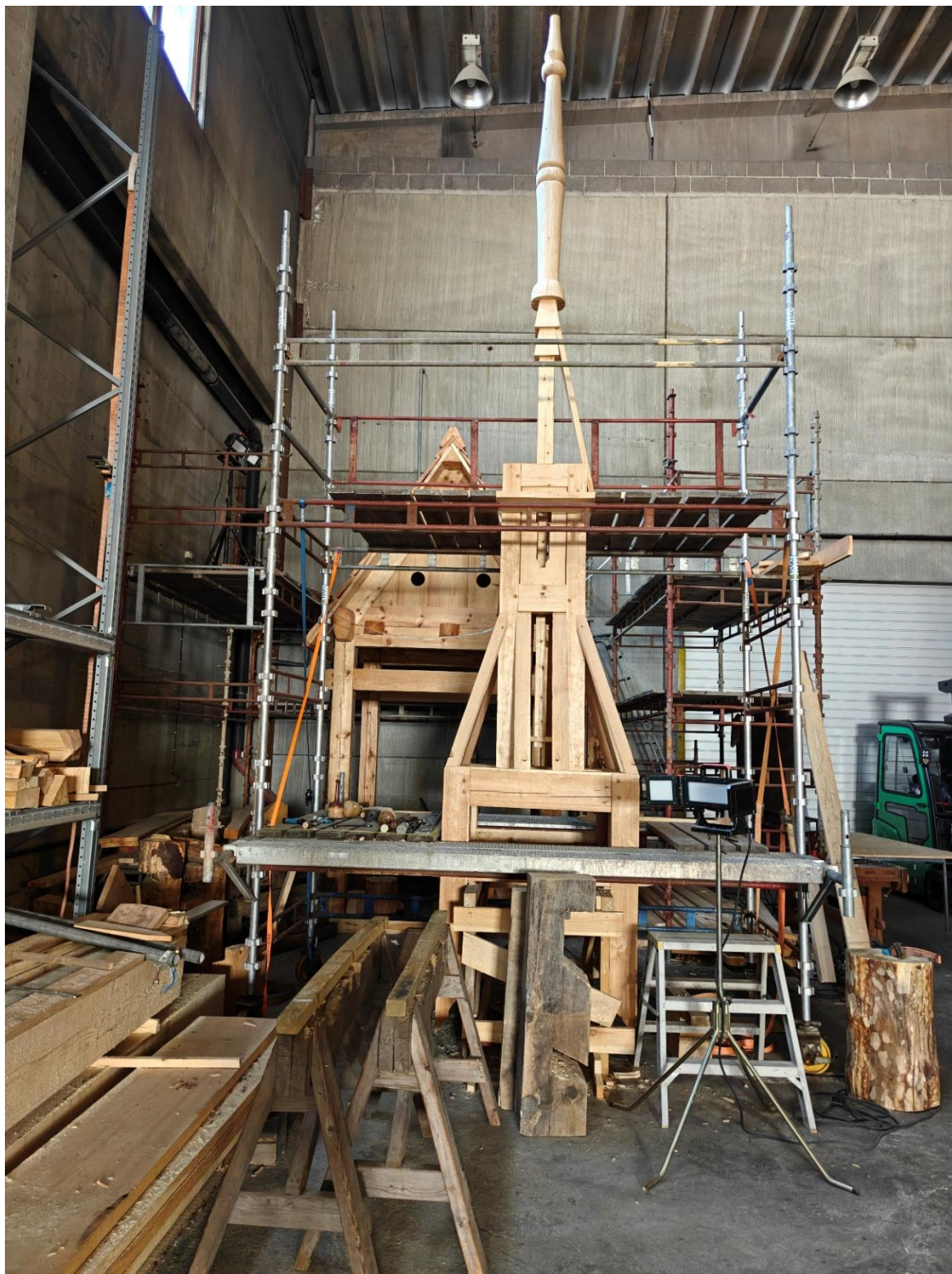
Bilde 91 Spirstanga montert. Sperrene til den midterste høyden er også montert, og klar til bordteking. En kan såvidt se enden på spirstanga inne i den midterste delen.
