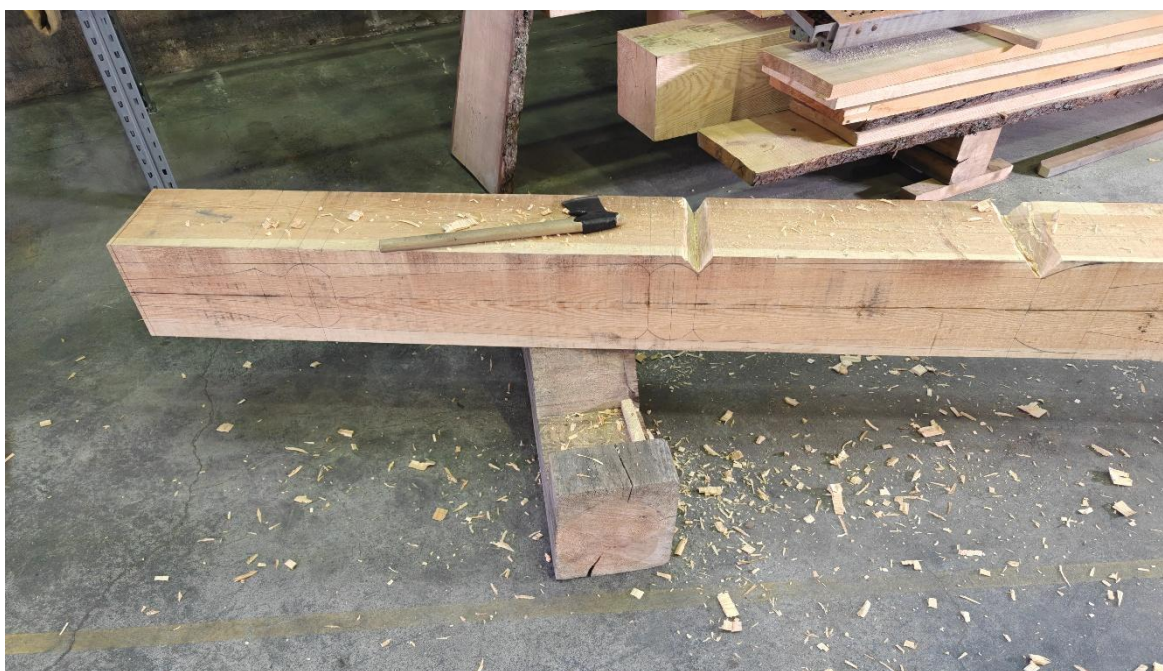
Bilde 85 Spesiell form på den øverste delen av spirstanga.
