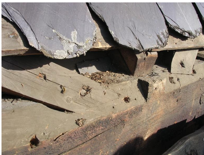
Bilde 15 Innfellingen og innfestingen av skråstreverene i Lomen stavkirke. Vi brukte denne løsningen på takrytteren da vi ikke hadde dokumentasjon på dette i Borgund. Foto Hans Marumrud
