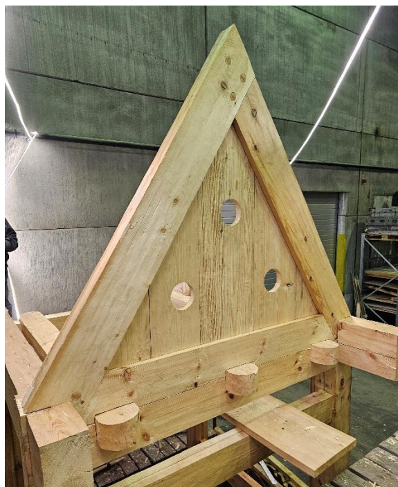
Bilde 52 Gavltrekanten på plass. På grunn av noen manglende mål av toppsvilla, ble gavltrekantene tatt av igjen, og toppsvilla formet ferdig.
