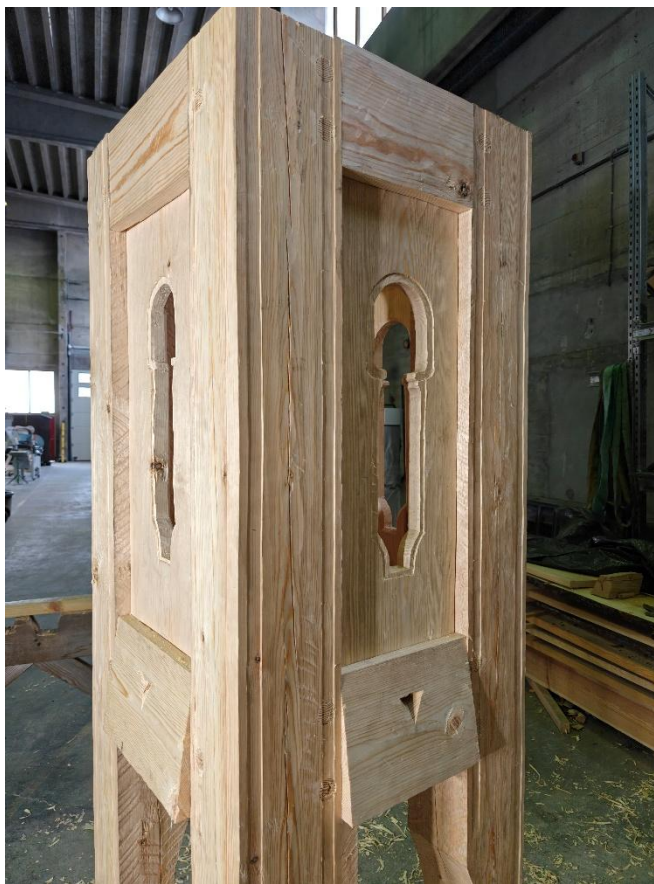
Bilde 81 På alle fire sidene er det felt inne utskjærte bord. I motsetning til de to høydene under, er disse bordene felt inn i bunn og toppsvill. Det er derfor lagd ventilasjonshull i bunnsvilla.
