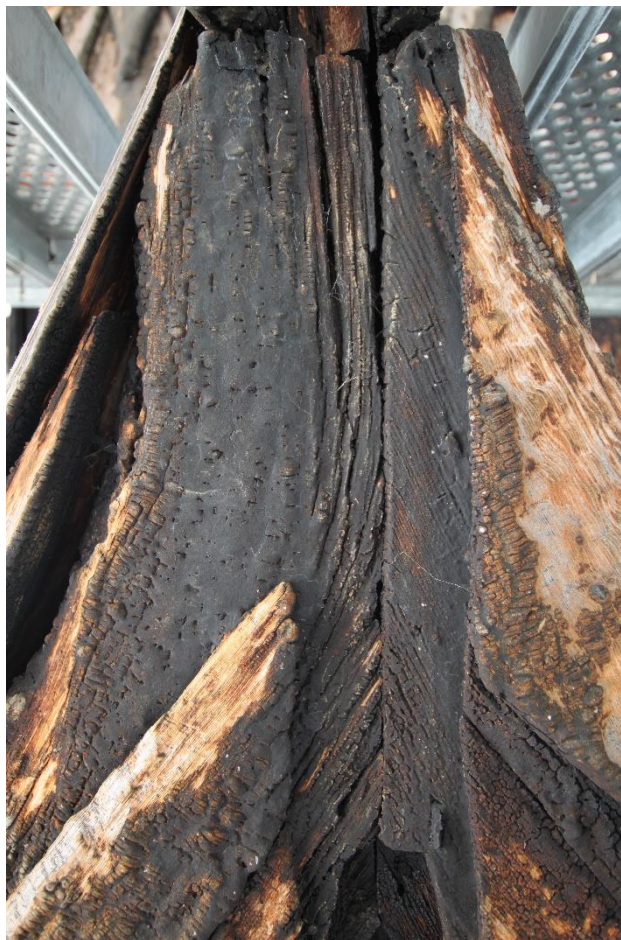
Bilde 23 Nærbilde av toppen av vindskiene på skipet. Til høyre ser det ut til at veden er relativt rettvokst, vi tolker det som et overdimensjonert emne. Til venstre bøyer årringene opp mot toppen, og vi tolker det som en rot. Foto Hans Marumsrud
