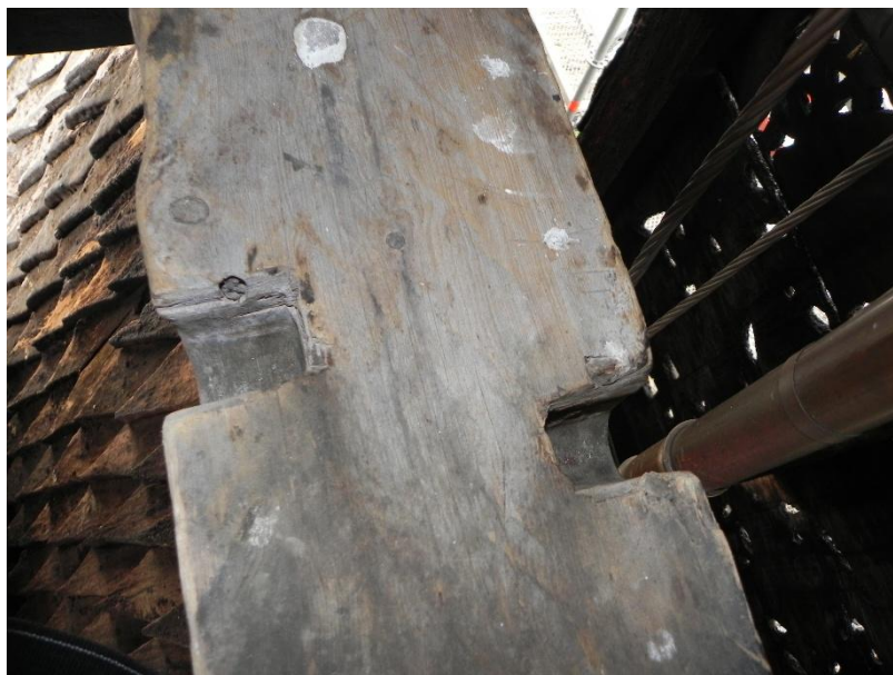
Bilde 51 Uthakingen til akslingen i klokkebjelkene. Foto Hans Marumsrud.
