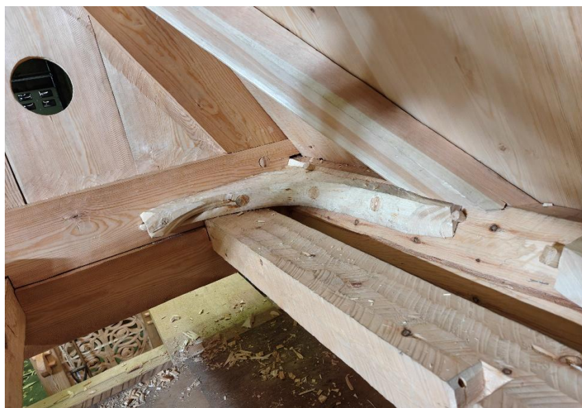
Bilde 54 Til høyre ser en hvordan skråstreverene er felt ned i toppsvilla. Ut mot takflaten er det en tapp som er hogd inn i toppsvilla, mens på innsiden er den haket imot falsen på toppsvilla.
