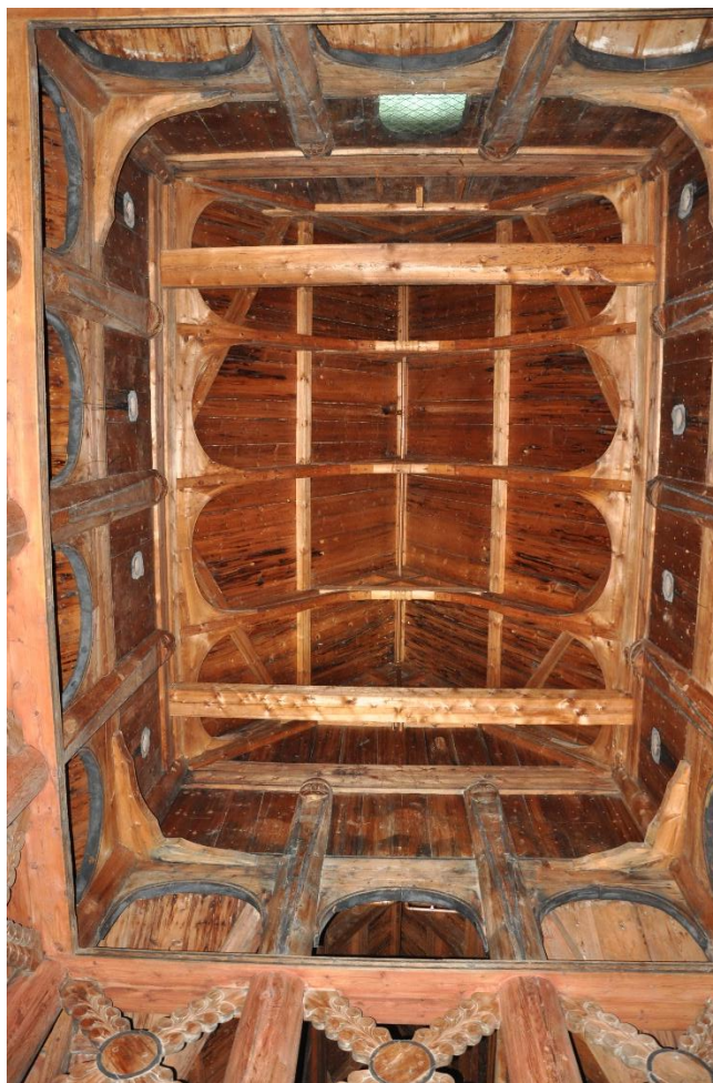
Bilde 67 Takkonstruksjonen i Borgund. Alle buene en ser på bildet er rotknær, pluss noen til.
