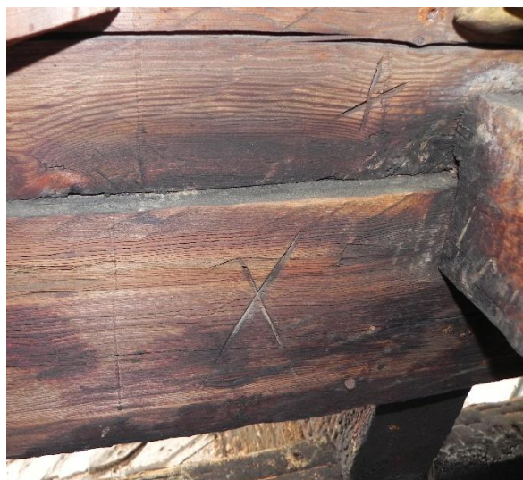
Bilde 43 Merking av svill og bindebjelke i gavlen i takrytteren. Foto Hans Marumsrud
