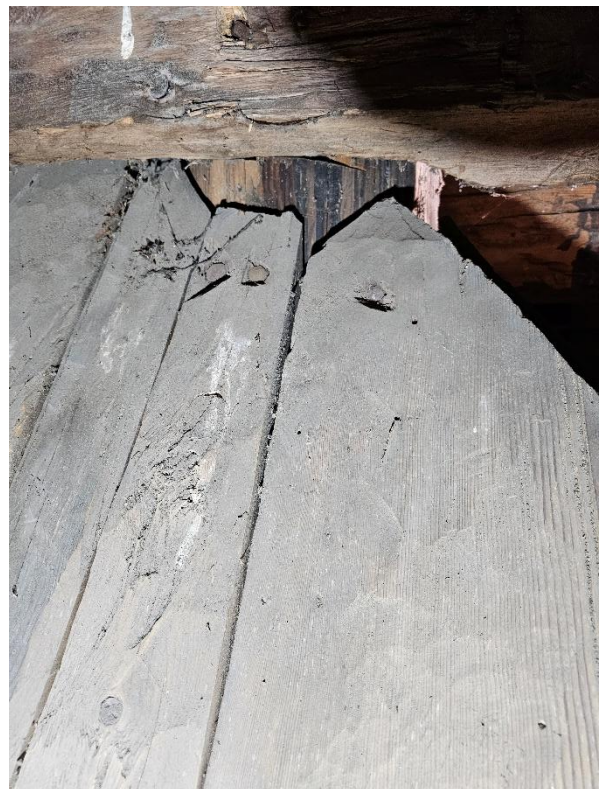
Bilde 42 Sperra og den stående taktroa i Lomen stavkirke er spikret.
