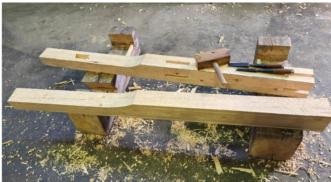
Bilde 44 En av stavene i øverste høyde er ferdig, den andre klar til å hogge tapper i.
