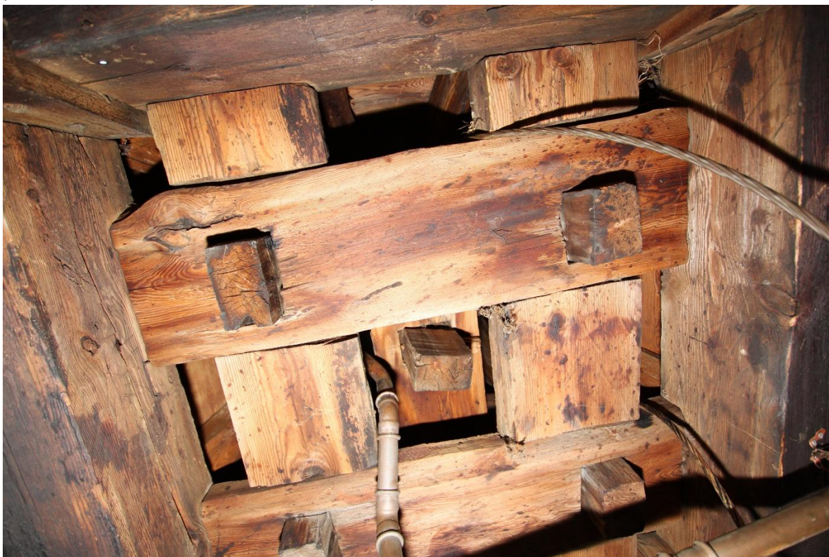
Bilde 74 De fire krysslagte plankene som bærer øverste høyde. I midten ser vi enden av spirstanga. Foto Hans Marumsrud
