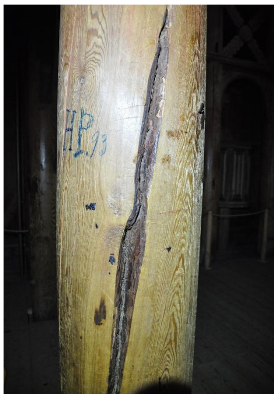
Bilde 18 Et tydelig eksempel på en høyrevridd stokk. Dette viser også litt av materialkvaliteten som er brukt i Borgund. Dette er en av innerstavene.
