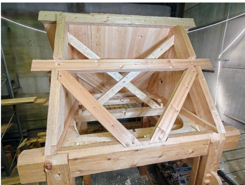
Bilde 57 Takkonstruksjonen klar til å kles med stående bordkledning. En ser her også skråstreverene som er tappet ned i den midterste klokkebjelken.
