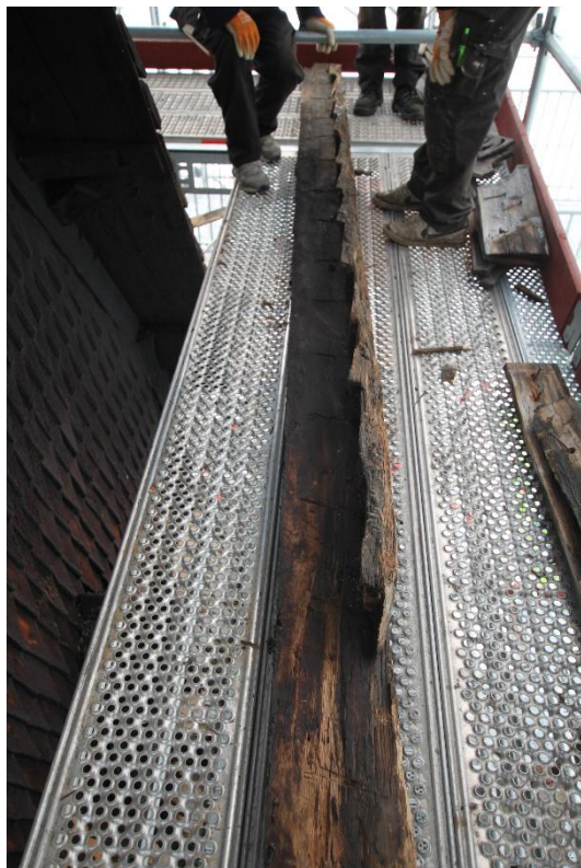
Bilde 63 På bildet ser en hvordan emnet både er vindski og isbord i et. En ser hvordan isbordet er meddratt og hogd etter den sulagte taktroa. Foto Hans Marumsrud
