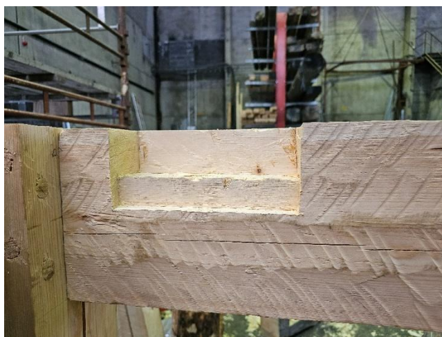
Bilde 75 Vi valgte å felle de to underste plankene i full dybde, 2 cm inn i toppsvilla, for å sikre tilstrekkelig bæring av øverste høyde.
