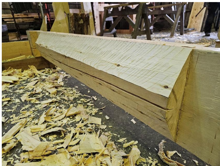
Bilde 49 Formen på toppsvilla på langveggen i den nederste høyden. Toppsvilla har denne formen mellom stavene.
