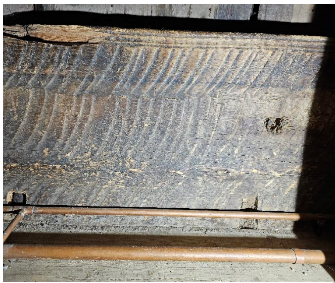
Bilde 38 Eksempel på spretteljing med en tilnærmet 90° vinkel.
