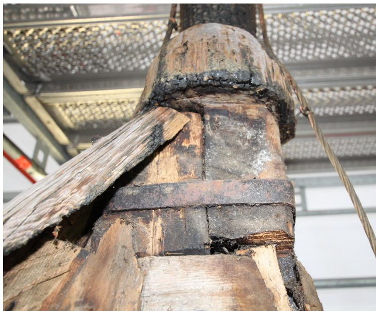
Bilde 84 Bladskjøten og stålbandet som holder spirstanga på plass. Foto Hans Marumsrud
