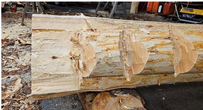
Bilde 33 Klampene hogges bort, og første reite med spretteljing hogges bort til neste klamp.
