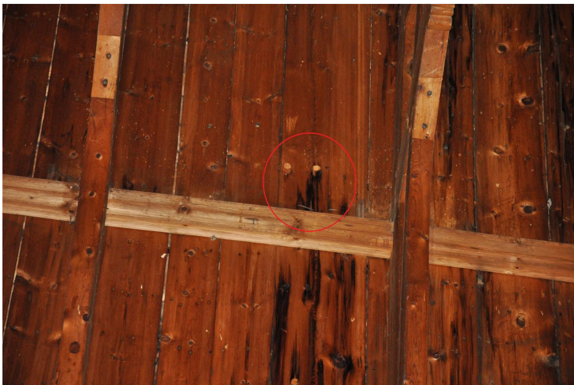
Bilde 48 Den røde ringen viser innfestingen av takrytteren til taket av skipet i Borgund. To 40 mm plugger og to spiker.
