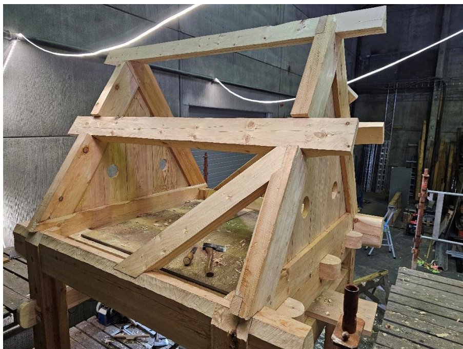
Bilde 55 Åsene og en av skråstreverene er ferdig felt ned. De ligger 3,5 cm under oversiden av sperrene. Ser en på toppen av gavltrekantene kan en se de to forskjellige løsningene for mønsåsen.
