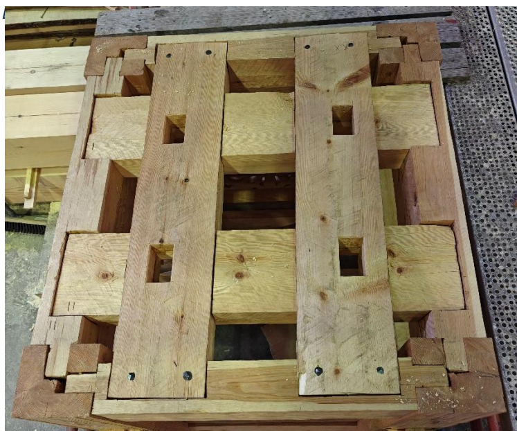
Bilde 77 Plankene ferdig nedfelt, og tappene for stavene til den øverste høyden er hogd ut. I stavene sees systemet for tappene til toppsvillene.
