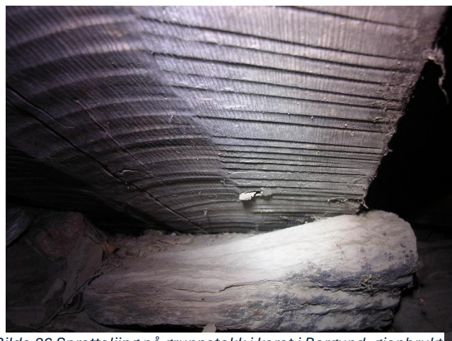
Bilde 36 Spretteljing på grunnstokk i koret i Borgund, gjenbrukt svill fra en tidligere kirke. Foto Hans Marumsrud
