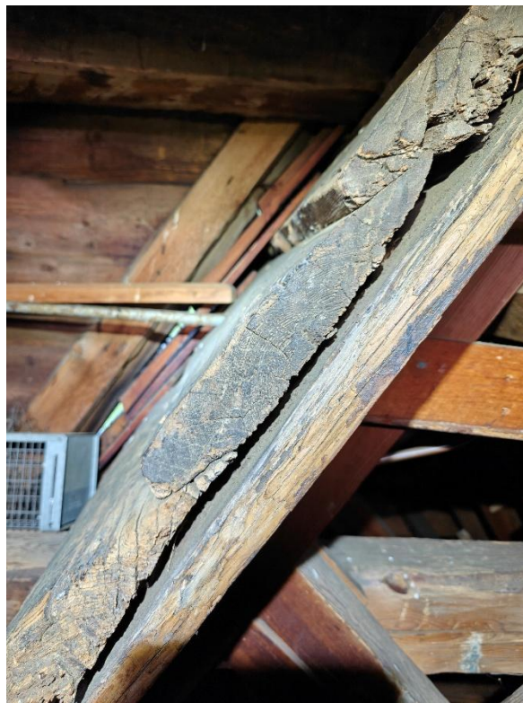
Bilde 60 Taktroa i Urnes stavkirke. Taktroa er en del tjukkere enn i Borgund, og er felt ned slik at baksiden ligger nedpå den stående taktroa.
