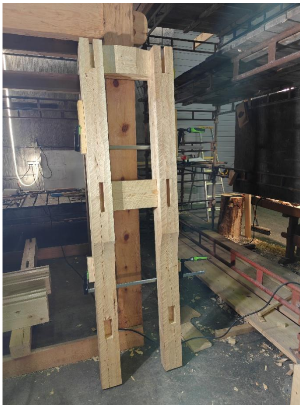
Bilde 79 En vegg klar til plugging. Under bunnsvilla ser en at dimensjonen er hogd ned.
