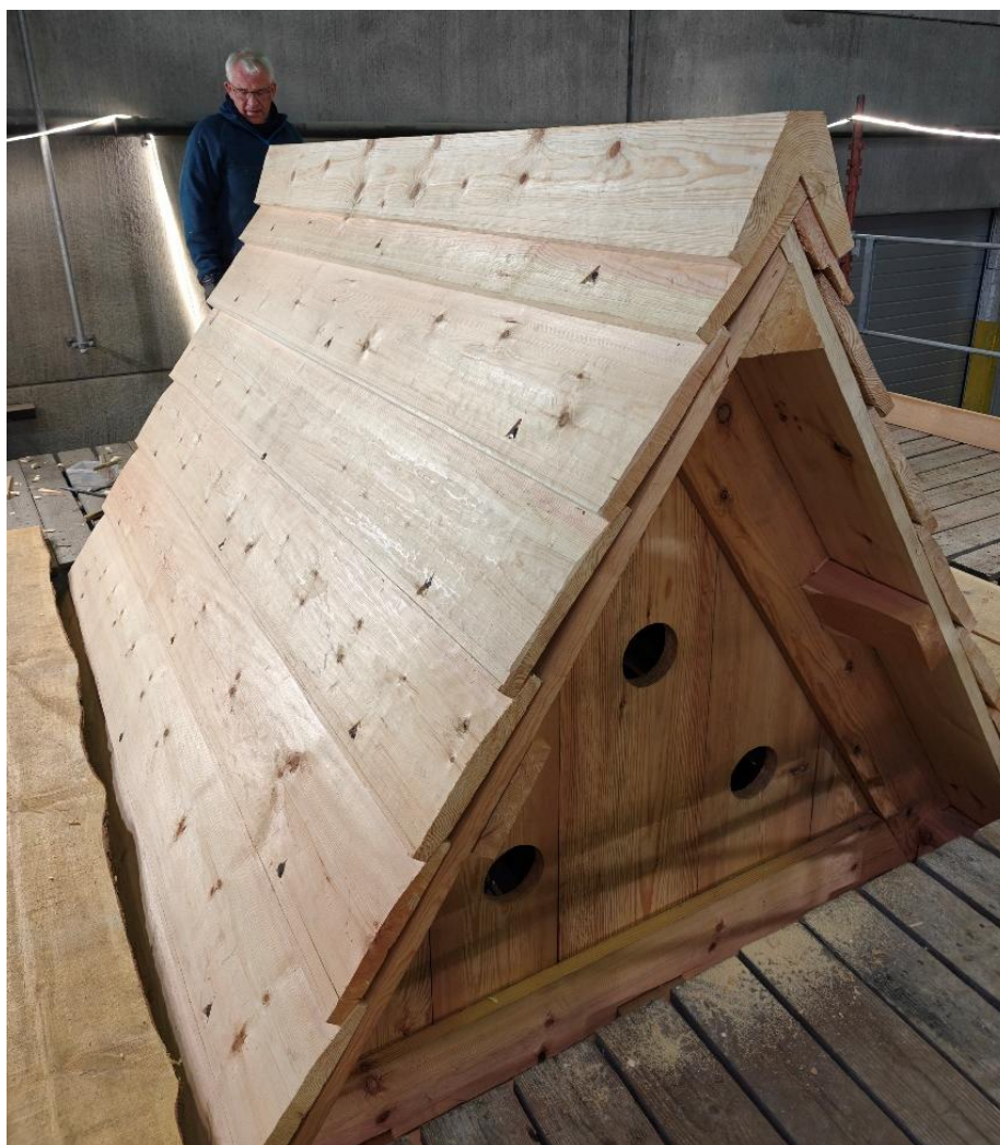
Bilde 62 Mønekjølen er ferdig tilpasset. Hans vurderer resultatet.
