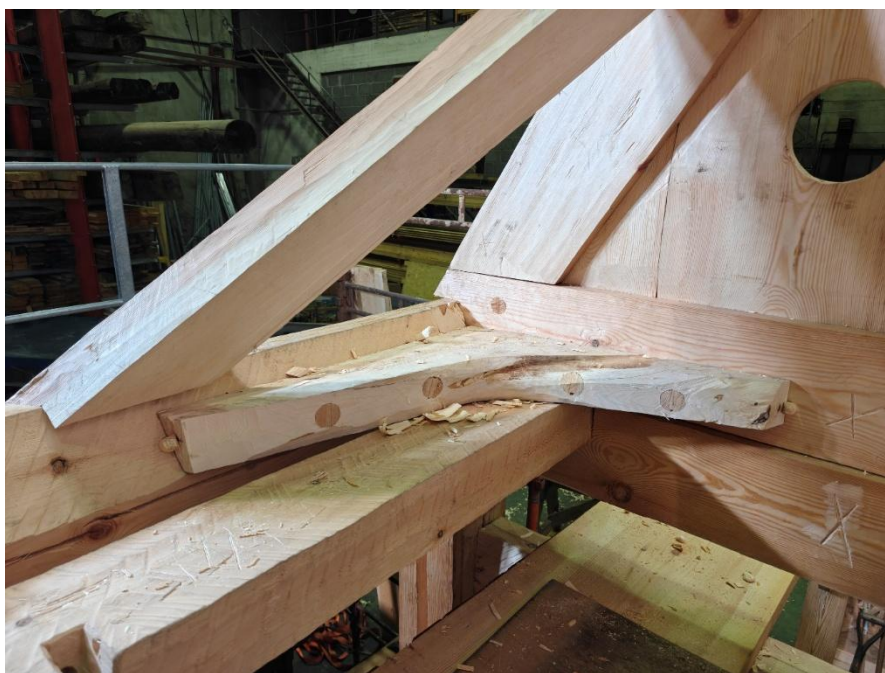
Bilde 71 Rotkne montert. I hver ende og på oversiden sitter en liten kileformet plugg. Vi merker ved enden av kneet og borer med merket som senter. Deretter slås kilene inn slik at kneet strammes og holdes på plass før vi borer for de store pluggene.
