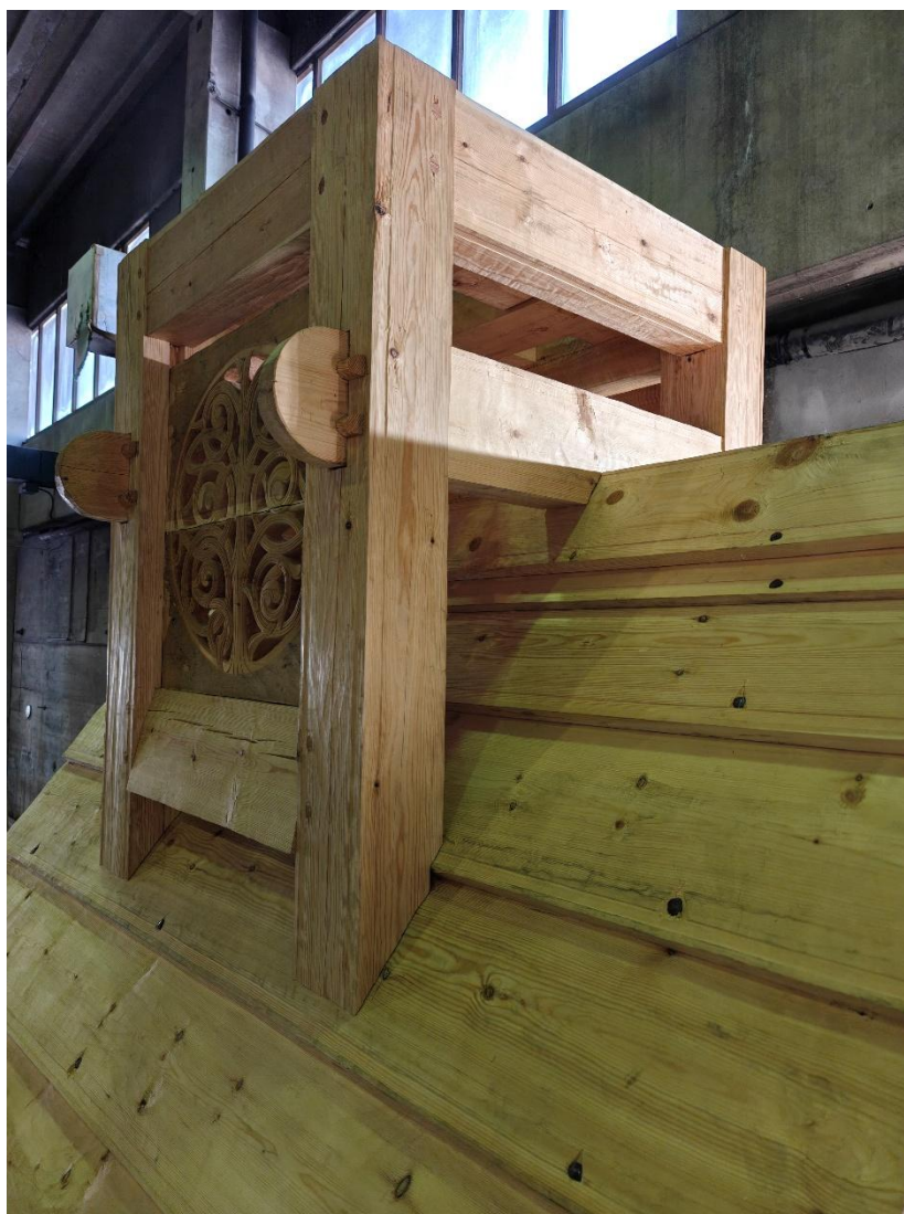
Bilde 72 Midtre høyde montert på nederste høyde. Stavene hviler over to trobord, og bunnsvilla på tvers av mønet er felt sammen med mønekjølen.
