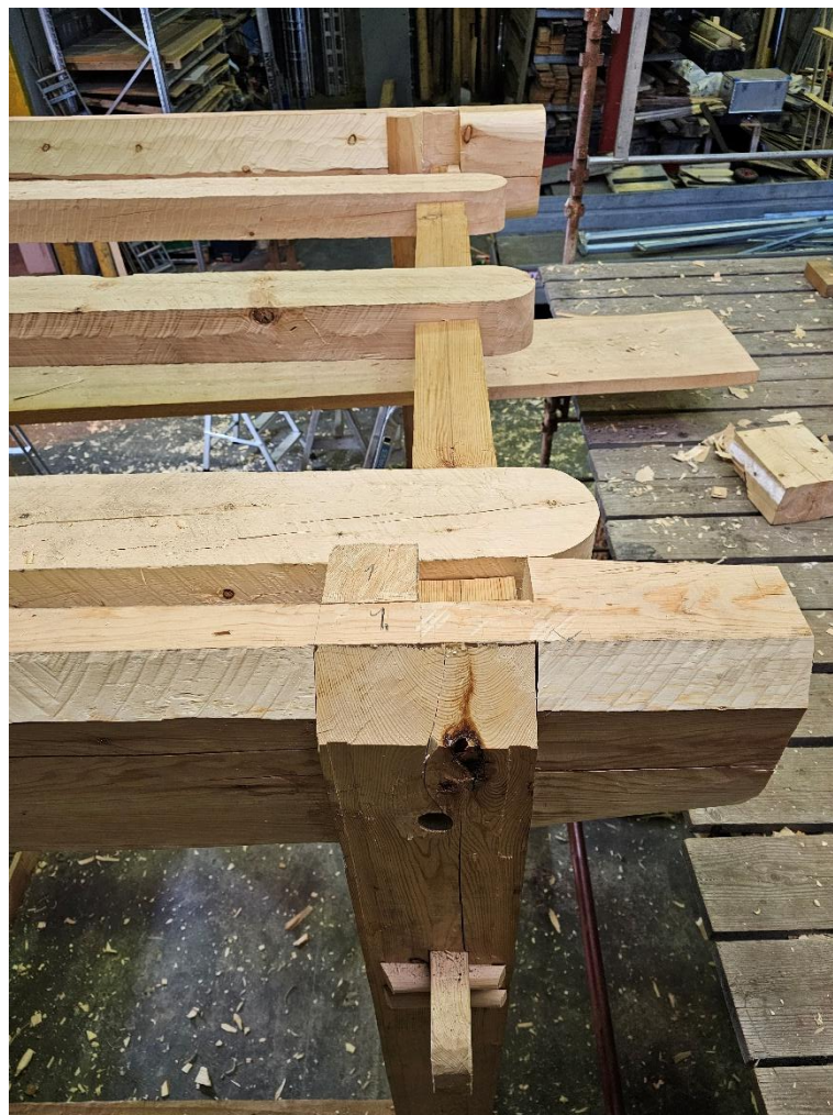
Bilde 45 Bindebjelken til gavltrekanen felles ned i staven, men holdes på plass utover av "novenden" på toppsvilla. Nederst på bildet sees også «strammepluggene» som låser bunnsvilla.
