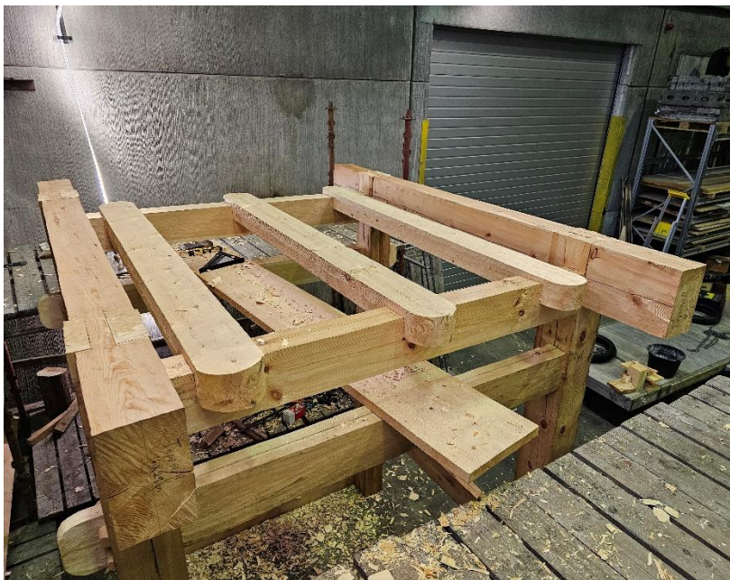
Bilde 50 Klokkebjelkene på plass og formet.
