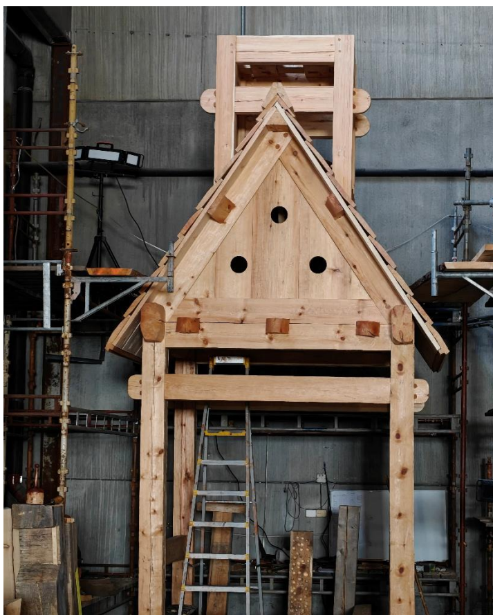
Bilde 47 Midterste høyde montert på nederste høyde.
