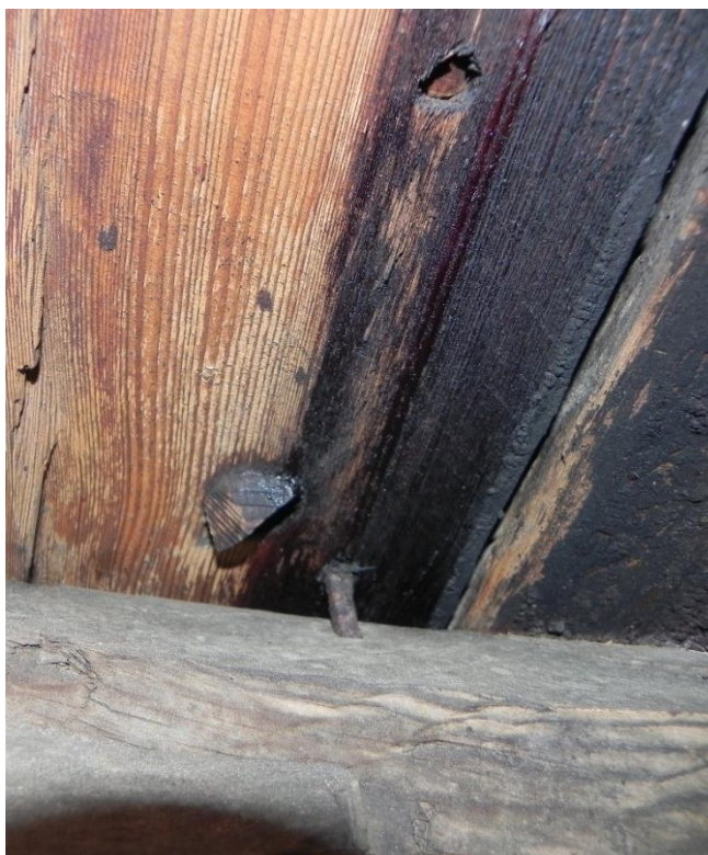
Bilde 24 Bilde av et gjenbrukt trobord i takrytteren, vi tolker det uthogde sporet til å kunne være et avhogd tilespor. Det er også mye tjære som vanskelig kan forklares med tjærebreng av dagens kirke. Foto Hans Marumsrud
