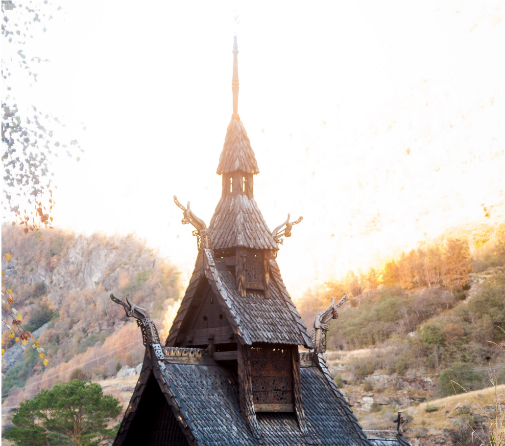
Borgund stavkirkes takrytter, og ornamentikk som knapt kan skimtes
