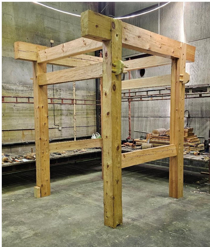
Staver og sviller montert, klart for klokkebjelker og gavler. Foto: Åsmund Stormoen.
