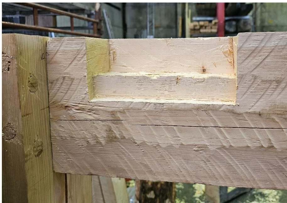
Innfellingen for bæreplankene i toppsvilla. Denne trappingen ble valgt for å styrke den nederste planken, som ville hatt lite bæreevne uten dette tiltaket. Foto: Åsmund Stormoen.
