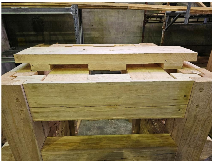
Nedfelling av planker som skal bære den øverste høyden av takrytteren. Foto: Åsmund Stormoen.
