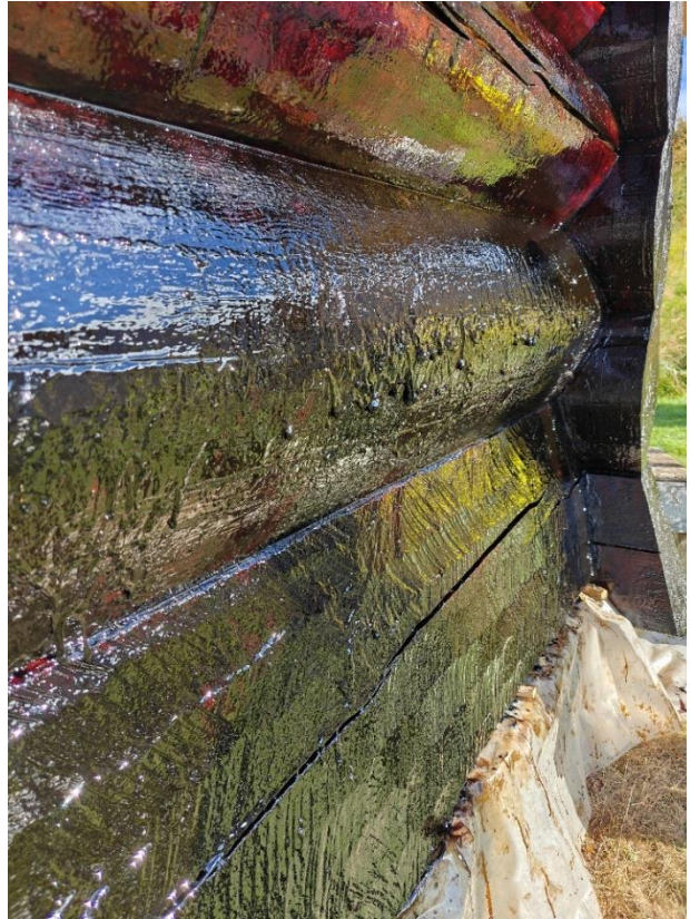
Den innkokte tjære begynte å renne da sola på veggen. Håpet er at hvis tjæra får tid til å herde uten for varmt vær, vil den sitte bedre. Foto: Åsmund Stormoen.
