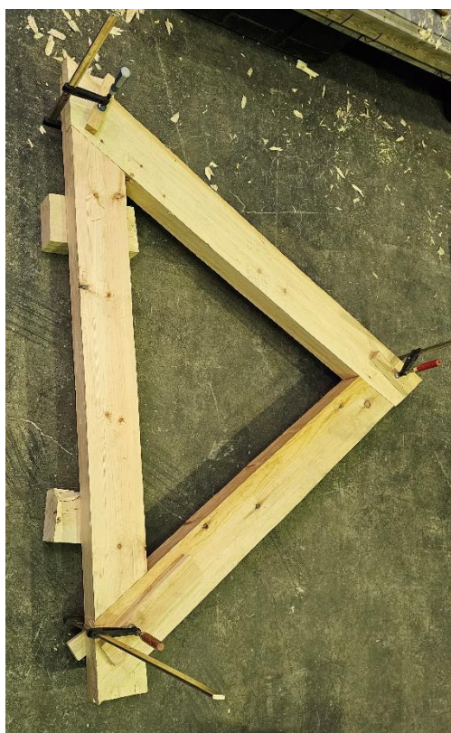
Bindebjelken og sperrene felt sammen. Etter dette merker vi opp tilesporet. Foto: Åsmund Stormoen.
