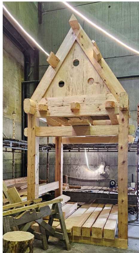
Oversiktsbilde av takrytterens nedre del. Foto: Åsmund Stormoen.
