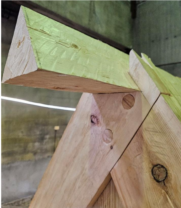
Sånn skal sammenføyningen mellom mønsås og sperrene se ut. Foto: Åsmund Stormoen.
