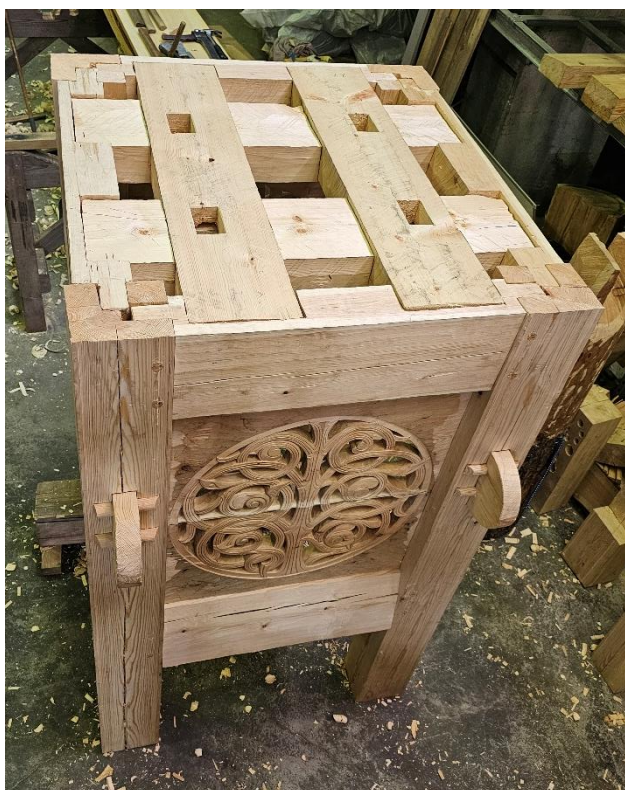
Bæreplankene ferdig montert. Stavene til den øverste høyden skal settes ned i tapphullene. Foto: Åsmund Stormoen.
