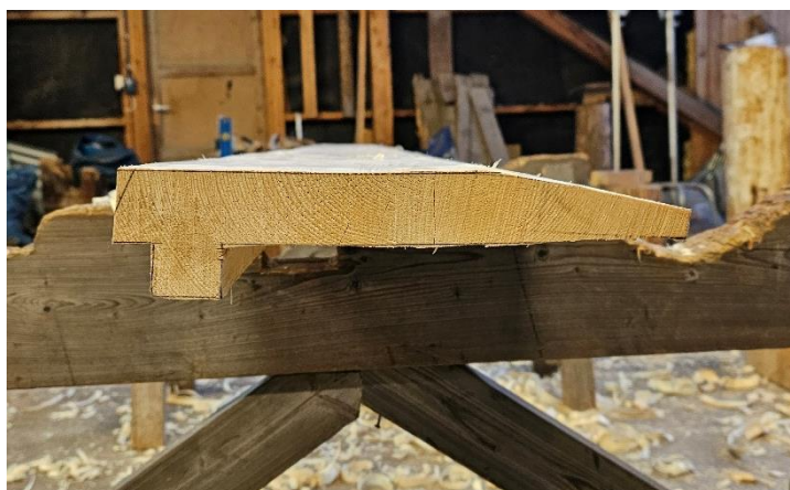
Det nederste sulagte taktribordet. Tappen på undersiden skal dekke den nederste enden av den stående taktrao. Foto: Åsmund Stormoen.
