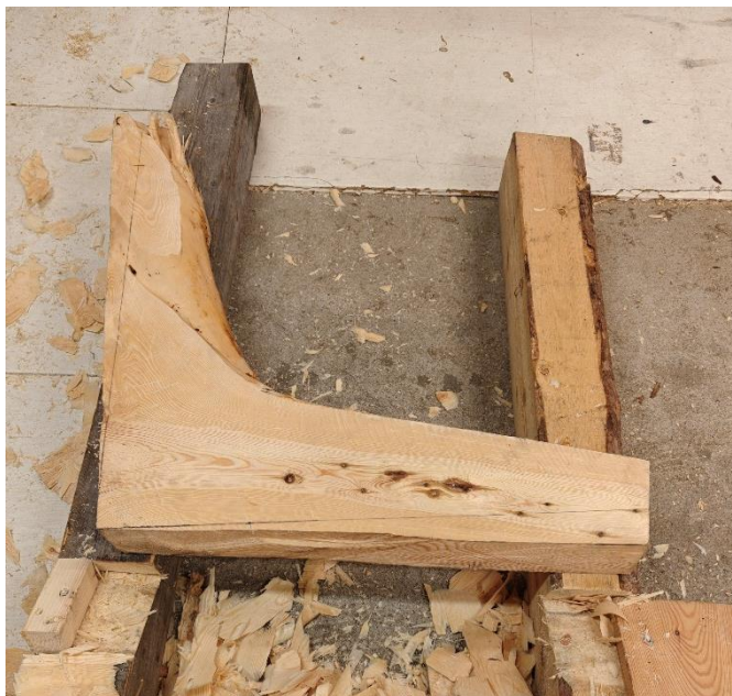
Rotkne ferdig tilhogd. Vinkelen på kneet blir justert ved innfelling i takrytteren. Foto: Åsmund Stormoen.
