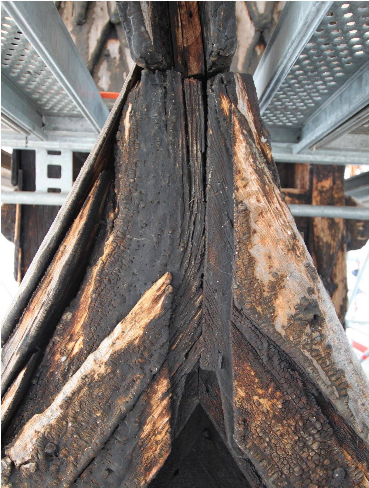
To forskjellige emner brukt som vindskier. Den til venstre er antagelig fra en stamme med rotjare, mens den til høyre er antagelig fra et stort emne. Foto: Hans Marumsrud.
