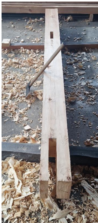
Toppen av staven med sporet til halsen i toppsvilla. Man ser så vidt merkene mellom tappene som skal bli tilespor. Foto: Åsmund Stormoen.
