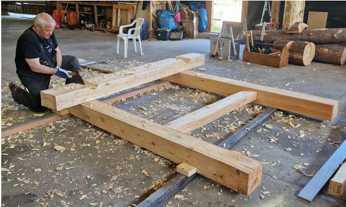
Tilhogging av halsen i toppsvilla som skal felles ned i toppen av staven. Bunnsvilla er allerede felt inn. Dette er et av sidefeltene. Foto: Åsmund Stormoen.
