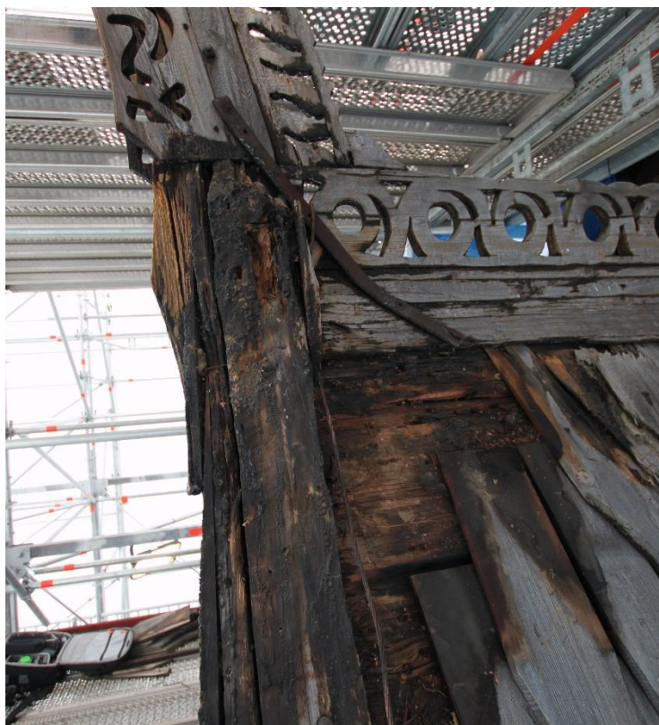
Sammenfellingen mellom vindski, drageskalle, mønekjøler, mønekam og "manen" på drakeskallen. Den er også meddratt ned over de liggende taktrobordene. Foto: Hans Marumsrud.
