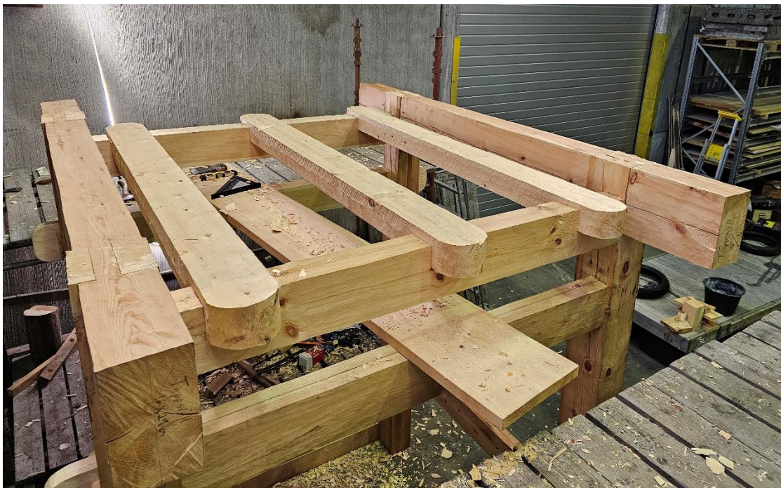
Klokkebjelkene ferdig felt ned i toppsvilla. Foto: Åsmund Stormoen.
