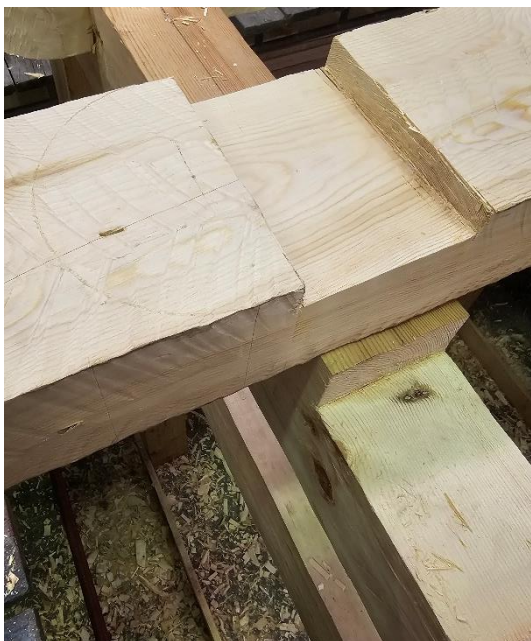
Klokkebjelkene blir felt ned i toppsvilla i gavlen. Den buede "novenden" er også merket og klar til hogging. Foto: Åsmund Stormoen.
