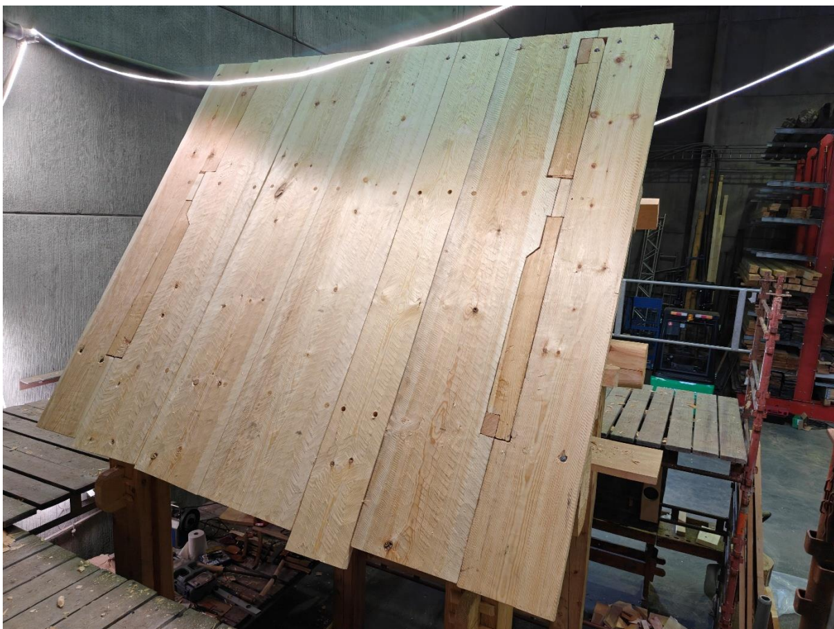
Den stående taktrao er ferdig på én side. Oppå denne skal det en liggende sulagt taktrao. Foto: Åsmund Stormoen.
