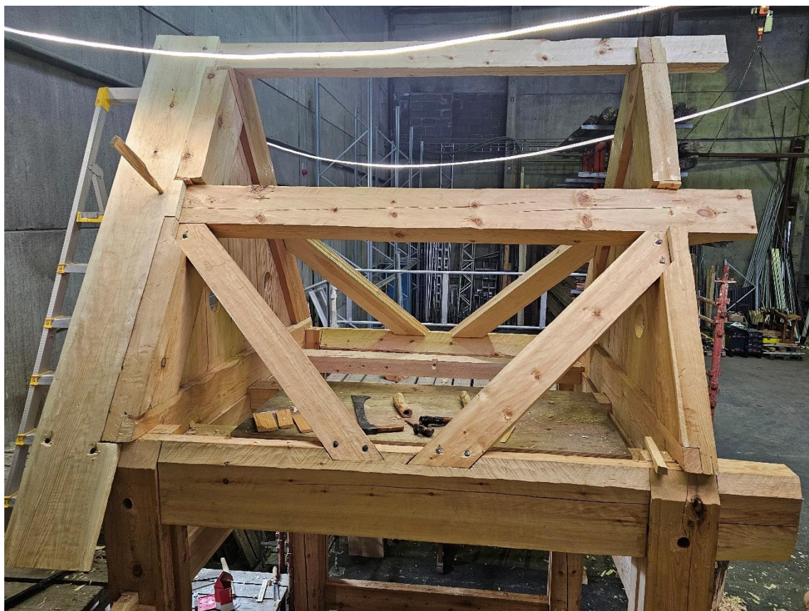
Slik er takkonstruksjonen. Som vist, ligger den stående taktroa jevnt med overkant av sperre. Oppå dette skal de liggende sulagt taktro. Foto: Åsmund Stormoen.
