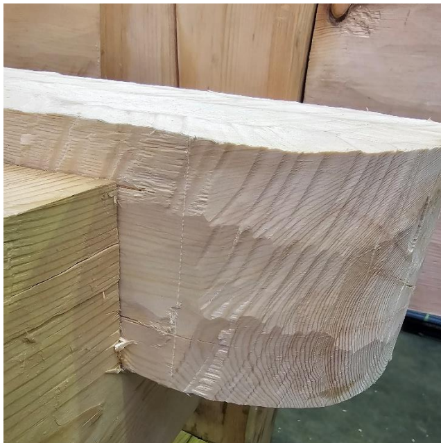
Klokkebjelke ferdig felt ned. Novendene er hogd runde. Foto: Åsmund Stormoen.
