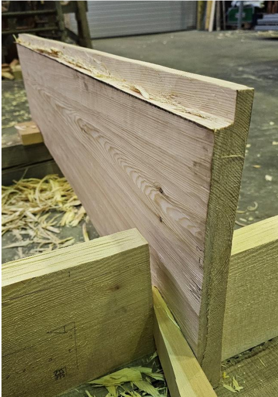
Hogging av falsen mellom veggtilene. Foto: Åsmund Stormoen.
