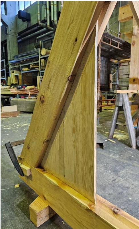
Tilpasning av veggtiler. Sett fra baksiden. Foto: Åsmund Stormoen.
