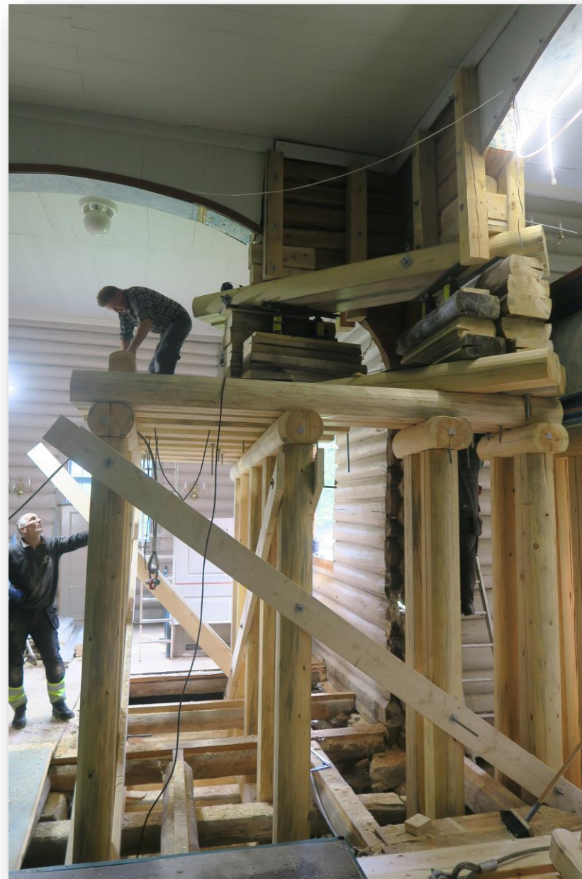
istandsetting av Ytre Rendalen kirke i 2023 Foto Alexander Myrseth, Riksantikvaren
