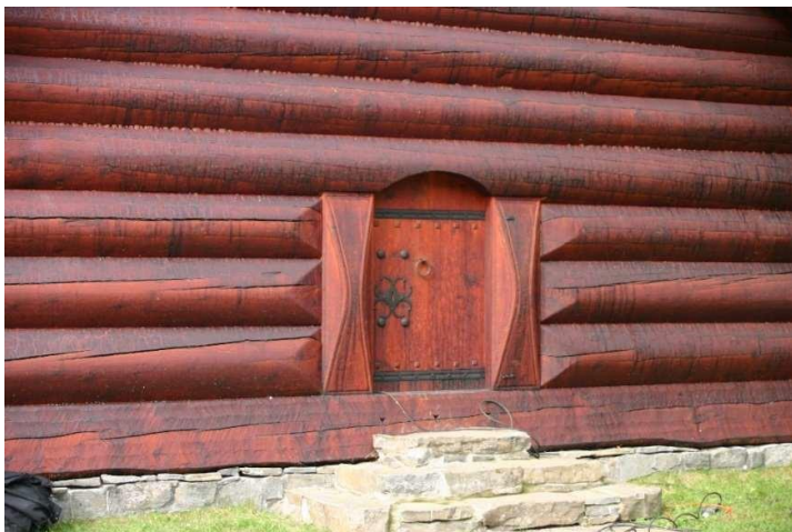
Gavlveggen. Ein ser dreneringshola i svilla under døra. Foto: Atle Ove Martinussen
