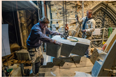
Nidaros Domkirkes restaureringsarbeider
