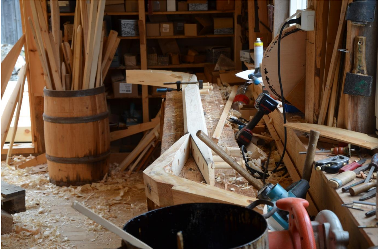
Bandsettet er ferdig felt, og plukkes ut for montering. Tre nagler på hver side gjør susen.
