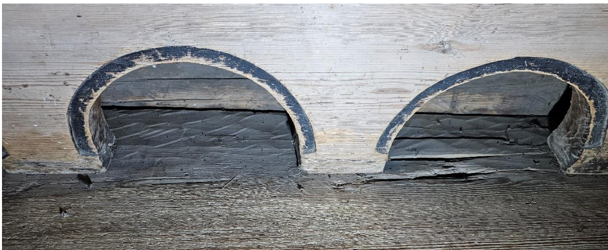
Bilde 22. Hoggemerker under benken, og skavlmerker foran benken. Bilde fra Torpo stavkirke. Foto Åsmund Stormoen.
