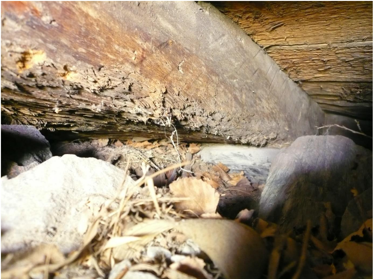
Bilde 18. Slepemerker på undersiden av en grunnstokk i Borgund. Foto Hans Marumrud.
