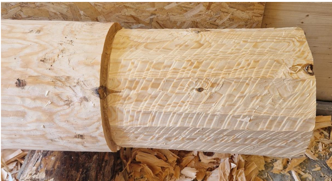
Bilde 60. Innhakkene til lamellene er ferdig hogd. Dette skulle bare vært gjort på den ytre 3/4 delen av staven, og ikke rundt hele. Foto Åsmund Stormoen.
