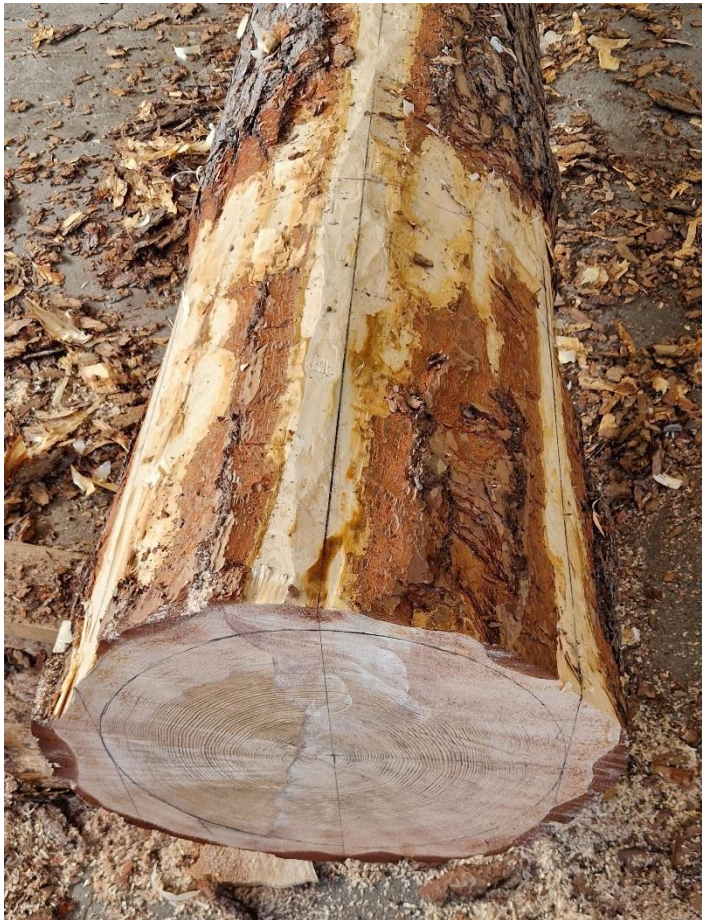
Bilde 35. Diameteren til basen er målt opp, ytterkantene er loddet opp og snorslått i lengden til basen. Foto Åsmund Stormoen.
