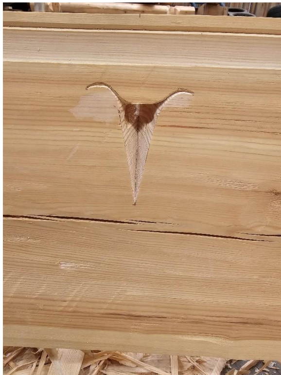
Bilde 45. Ventilasjonshull med dekor, etter mål fra Borgund. Foto Åsmund Stormoen.
