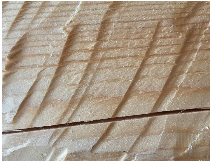
Bilde 16. Teljespor som har "forsjøvet" seg etter at tørkesprekken har oppstått. Foto Åsmund Stormoen.
