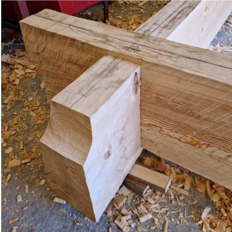
Bilde 58. Ferdig laftet sammen. Det er lagt inn litt sigemon siden emnene fortsatt var ganske ferske under sammenføyningen. Under ferdig montering var svillene på lik høyde. Foto Åsmund Stormoen.
