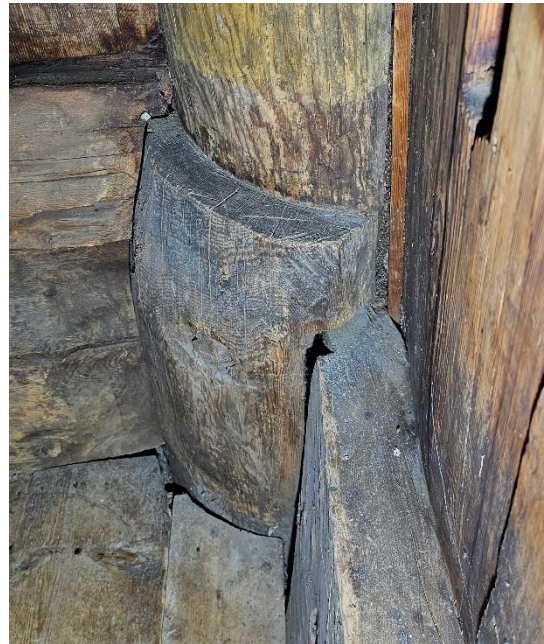
Bilde 28. Bilde av innhakning i svill mot stav i Torpo stavkirke. Dette er gjort på samme måte i Borgund. Foto Åsmund Stormoen.
