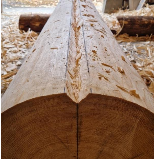
Bilde 44. V-sporet hogd til tilesporet. Foto Åsmund Stormoen.
