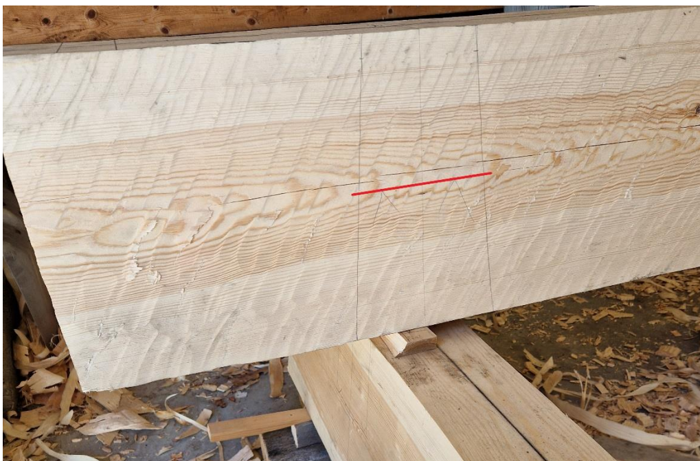
Bilde 54. Oppmerkingen av langsvillen ned over kortsvillen, den røde streken markerer hvor dypt halsen skal hogges.. Foto Åsmund Stormoen.
