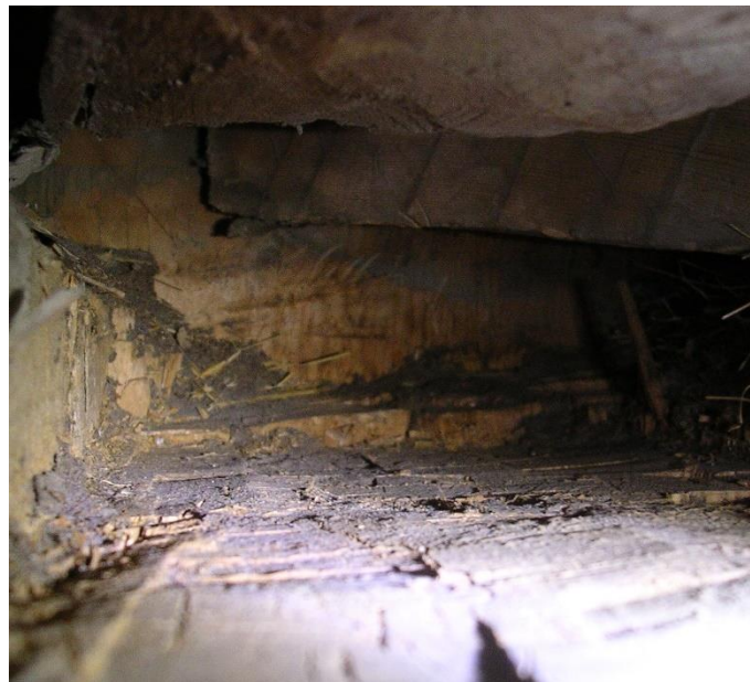
Bilde 27. Bilde inn i en av hjørnestavene i Borgund. Oppe i høyre hjørne sees gjæringen av motstøtende stav. I forgrunnen til venstre ser en spor etter hoggjern. Foto Hans Marumrud.
