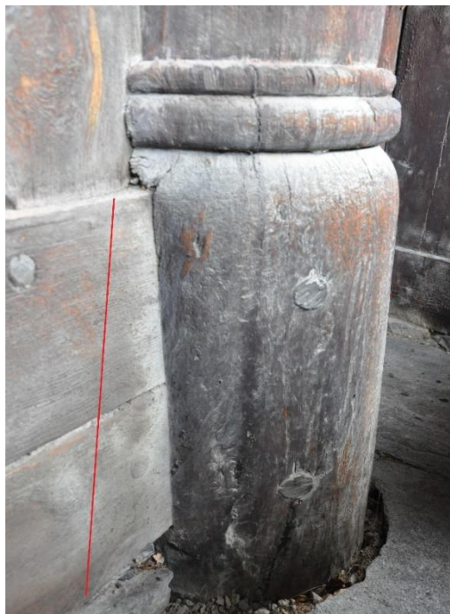
Bilde 29. Svill og stav i sørøst-hjørnet i Borgund. Den røde streken indikere hvor kinningen er. Foto Åsmund Stormoen.
