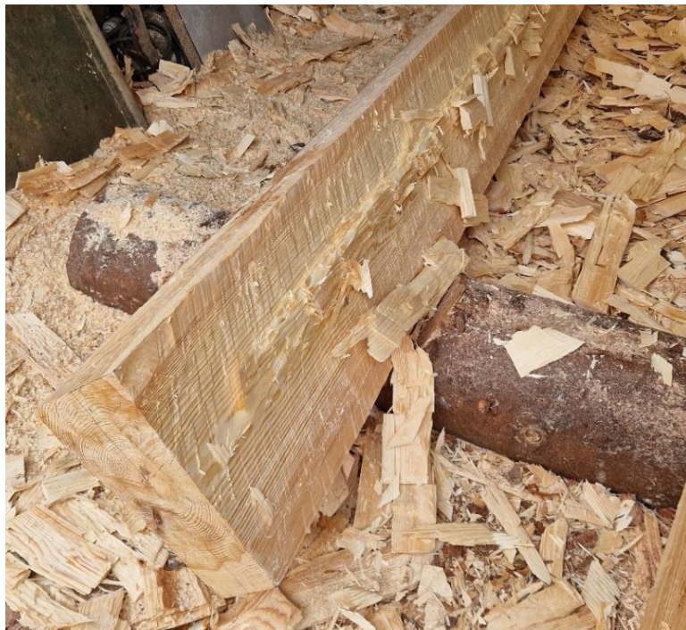
Bilde 25. Øverste del av svillen er hogd. Stokken er snudd og det hogges mot den ferdigteljede halvdelen. Foto Åsmund Stormoen.
