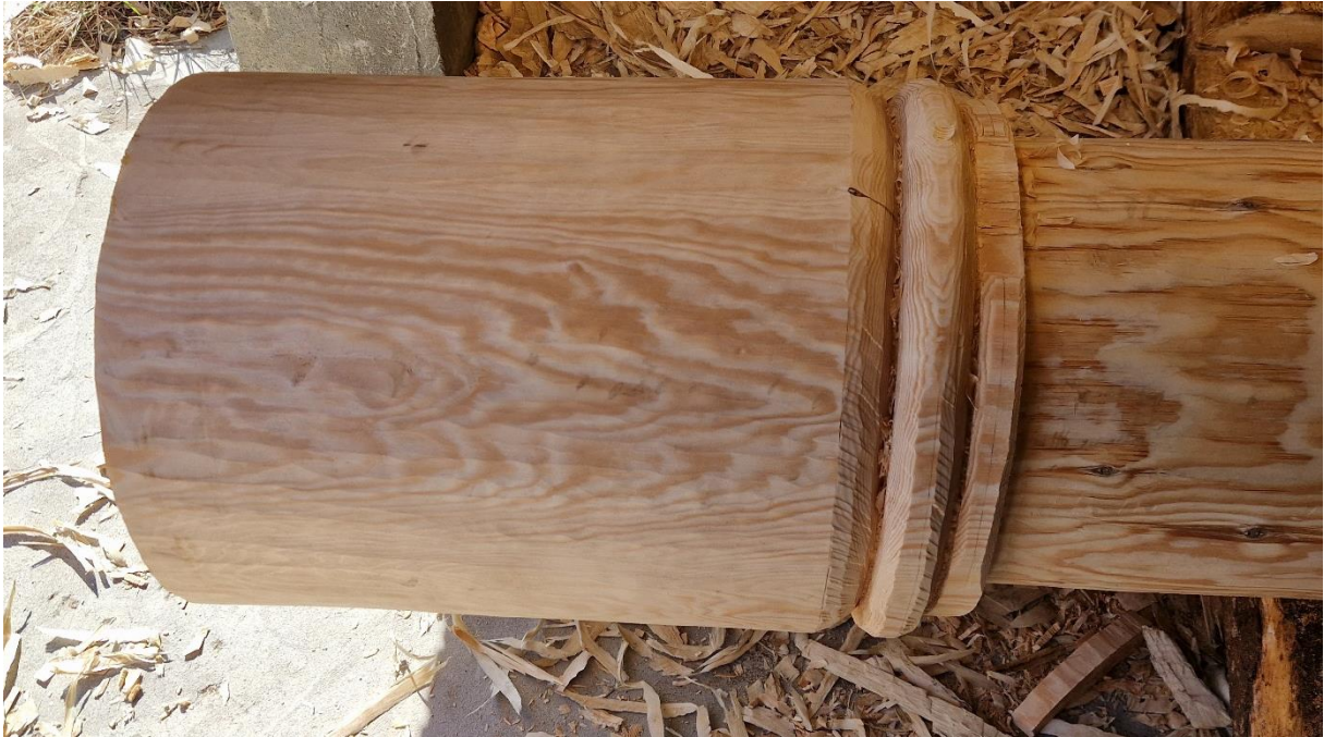
Bilde 41. Grovforming av vulstene med øks. Foto Åsmund Stormoen.
