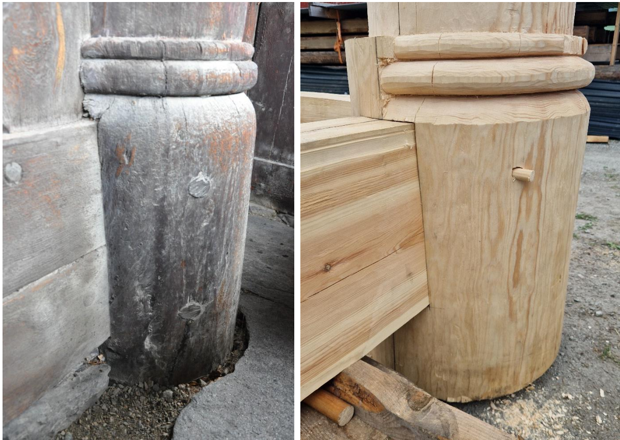
Bilde 64. Sammenligning av den originale stav og svilløsningen, mot arbeidsforsøket. Trenaglen som er satt i er mindre enn de originale. Disse hullene skal bores opp med 40mm bor, så de blir tilsvarende de originale fra Borgund. Foto Åsmund Stormoen.
