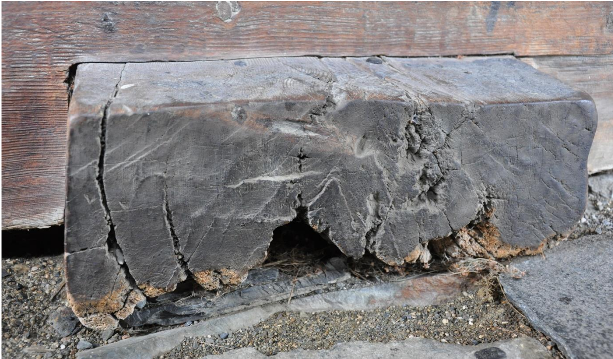
Bilde 52. En av grunnstokkene i Borgund. Hoggemerker ovenfra og fra siden, og store utrivninger under. Foto Åsmund Stormoen.
