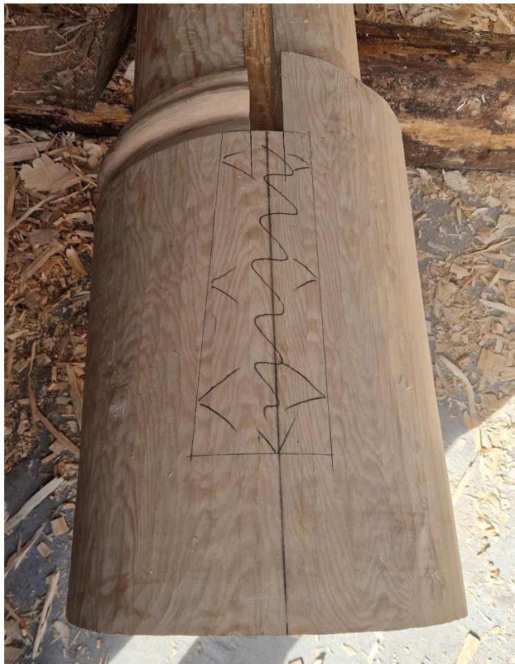
Bilde 46. Tapphullet i staven er merket, og klar til hogging. Foto Asmund Stormoen.
