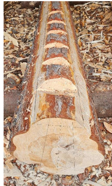
Bilde 19. Klamphogging av svill. sotsnor merkene blir brukt som dybdemerker for hvor dypt en skal hogge. Foto Åsmund Stormoen.
