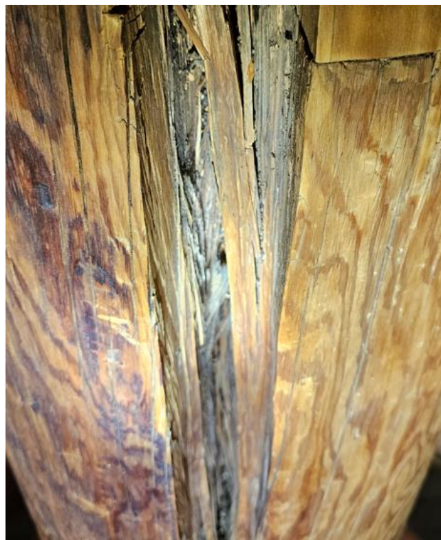
Bilde 42. Hoggspor i siden av tilesporet i Høre stavkirke. Foto Åsmund Stormoen.
