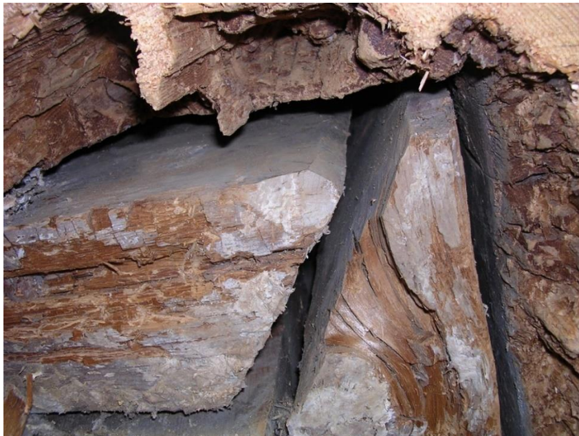
Bilde 32. Gjæret svilløsning i Lomen stavkirke sett fra undersiden. Foto Hans Marumsrud.
