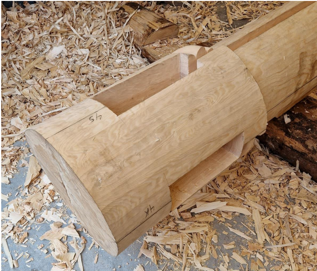
Bilde 47. Tapphullene ferdig hogd. Foto Åsmund Stormoen.
