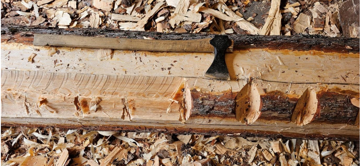
Bilde 24. Klampene hogges bort, og første reita spretteljes samtidig. Foto Åsmund Stormoen.
