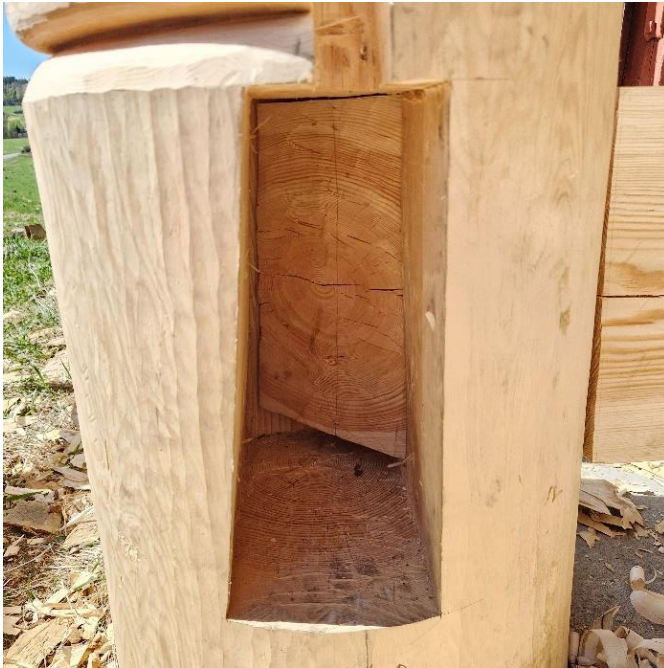
Bilde 50. En svill ferdig tilpasset inn i staven. Foto Åsmund Stormoen.
