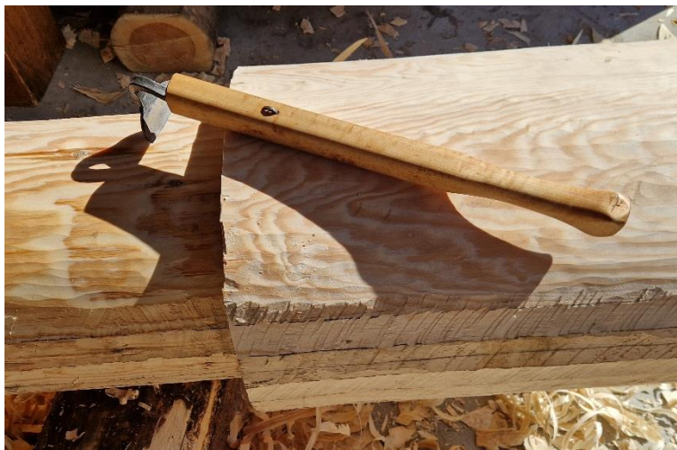
Bilde 39. Pjålen brukes i overgangen mellom stav og base. Foto Åsmund Stormoen.
