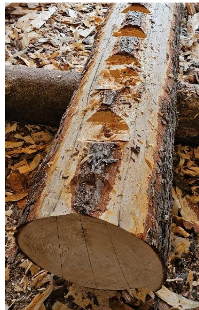
Bilde 23. Oppmerking, og klamphogging ferdig. Foto Åsmund Stormoen.
