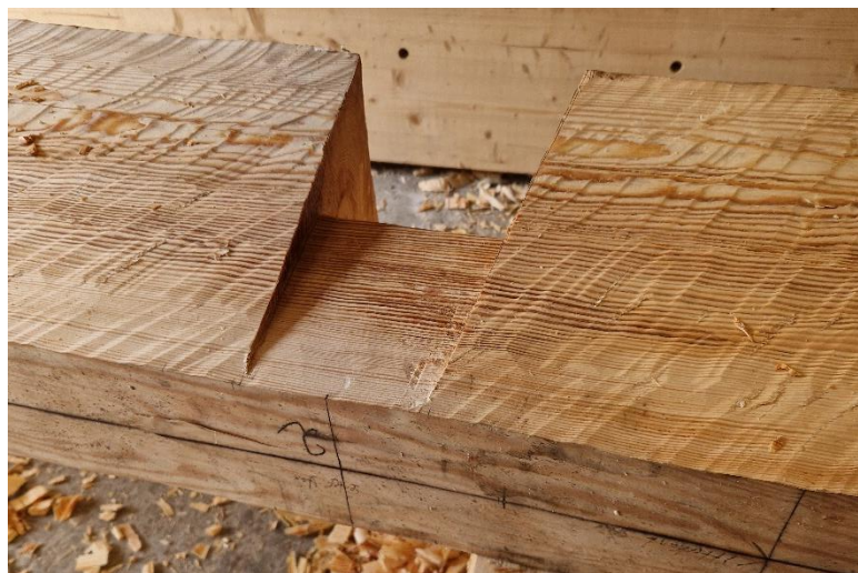
Bilde 57. Ferdighogd sammenføring i langsvillen. Foto Asmund Stormoen.
