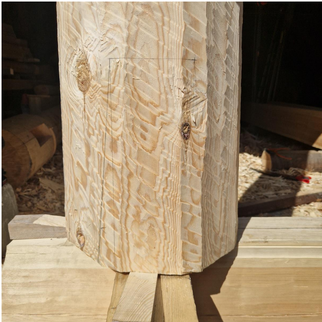
Bilde 61. Oppmerking for nedfelling av stav over svill. Foto Åsmund Stormoen.
