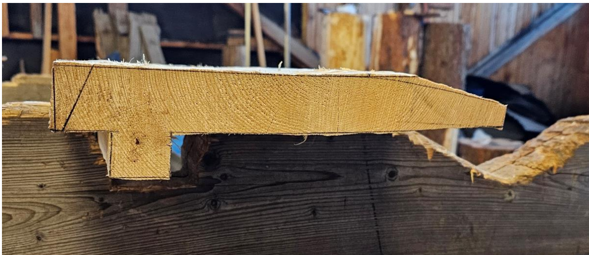
Bilde 14. Eksempel på takbord. Dette er det nederste liggende trobordet, kanten under skal ligge imot den stående troa under. Foto Åsmund Stormoen.
