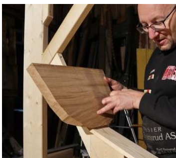
Forspeilets underside felles mot kjølbordet i prammens baug.
