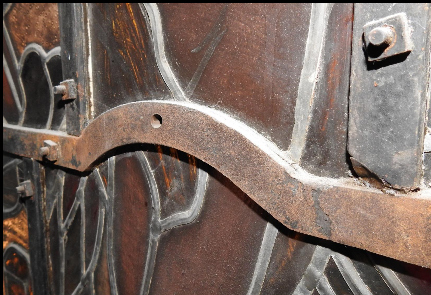
Forskjellige andre aspekter - manglende skruer, beslag og netting som ruster
