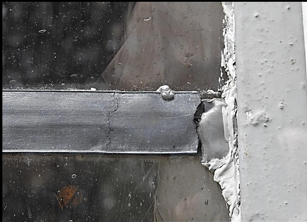
Bly – blybrudd, materialtretthet, deformasjoner, fugler.
