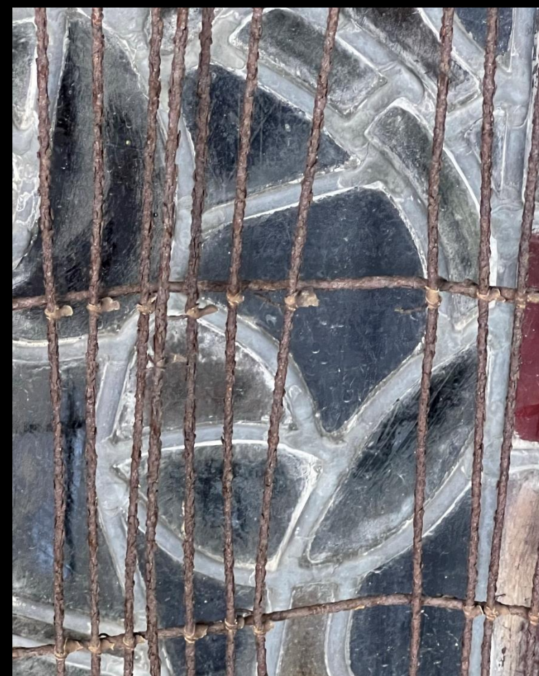
Forskjellige andre aspekter - manglende skruer, beslag og netting som ruster
