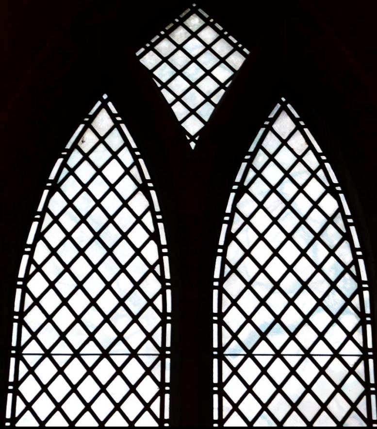
Bergen domkirke, ukjent håndverker, trolig 1870.
