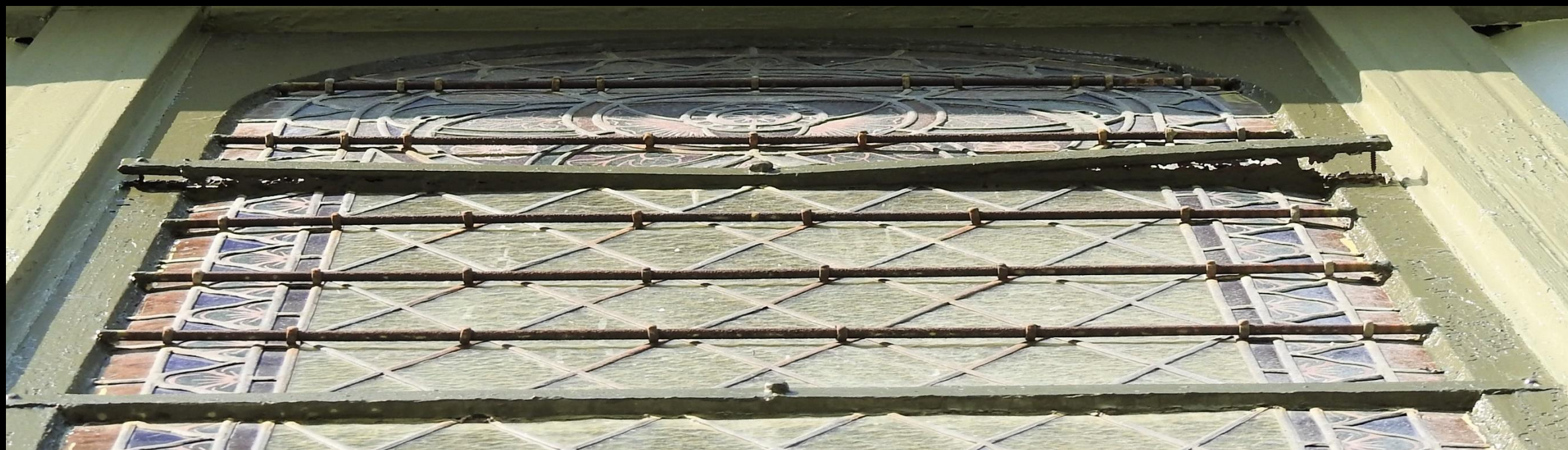
Forskjellige andre aspekter - manglende skruer, beslag og netting som ruster
