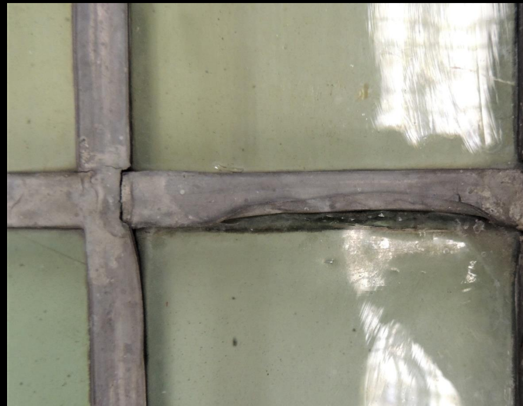
Bly – blybrudd, materialtretthet, deformasjoner, fugler.
