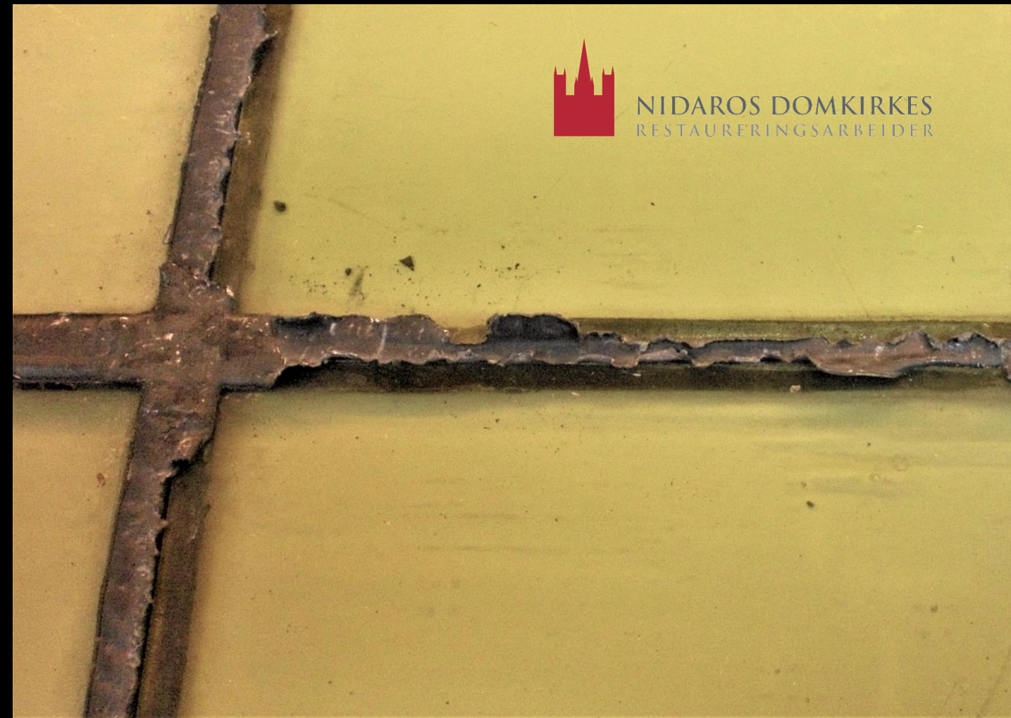
Bly – blybrudd, materialtretthet, deformasjoner, fugler.
