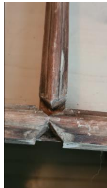
Hjørne og srossesammenføyning, nakking, gjæring og kontraprofil
