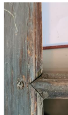
Hjørne og srossesammenføyning, nakking, gjæring og kontraprofil
