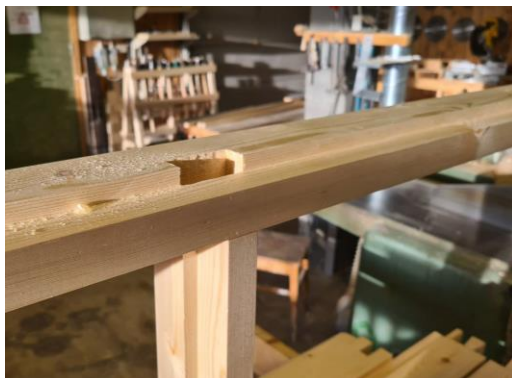
Tapphull for losholt eller post.
