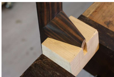
Klossen og hælen ferdig tilpasset
