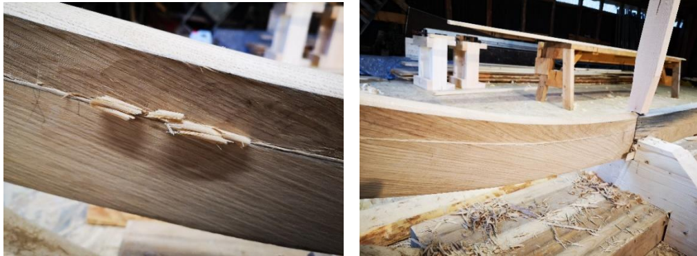
Arbeid med halvspaning i framlotet.
