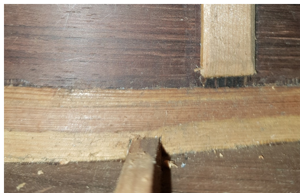
Detalj: Laminerte lister på anonym fransk gitar
