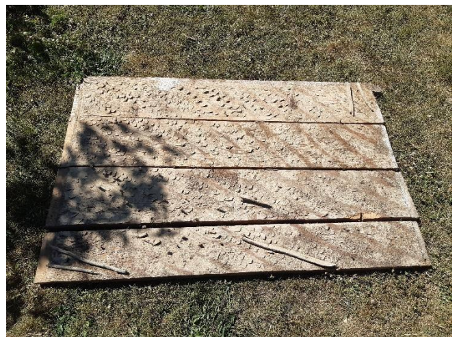
Det ene veggrommet, som er i furu, med opphugging av flaten for å få leiren til å feste, og med påspikret kvist og kvast, som armering.
