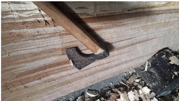
Tilhogging av plankene til baldakinen.
