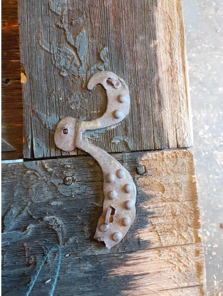
Nøkkelanviseren fra låsen har blitt gjenbrukt som hjørnebeslag nederst på døra.
