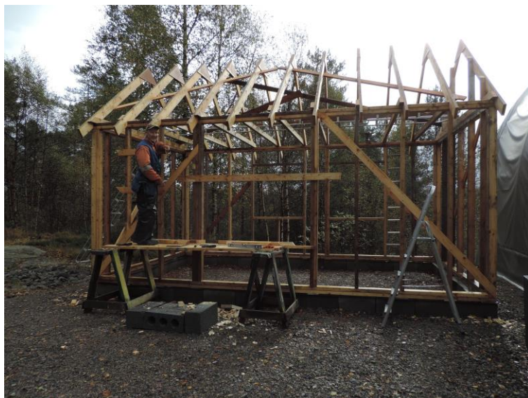
Oktober 2017: Børsemakaren har planert grunnen, fått opp ein ringmur i Leca og har fått opp reisverk av forskalingsmaterial han har resirkulert. Sperr med treungs røst. (sperrrelengd=3/5 av breidda til huset)
