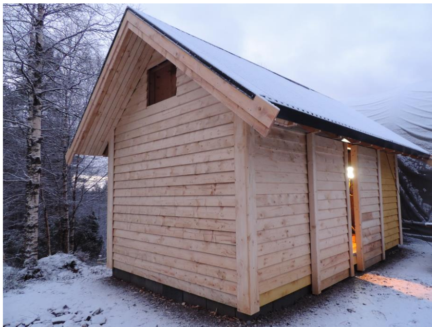
Desember: Taket er komme på, kisteborda på austre gavlen på plass, glas og dørar i, ferdig isolert og golvet av heimeskoren gran i 2"x6".
