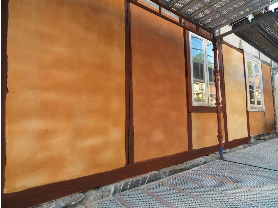
Aktive kalk- og temperaflater under opptørking i vakkert kveldslys.
