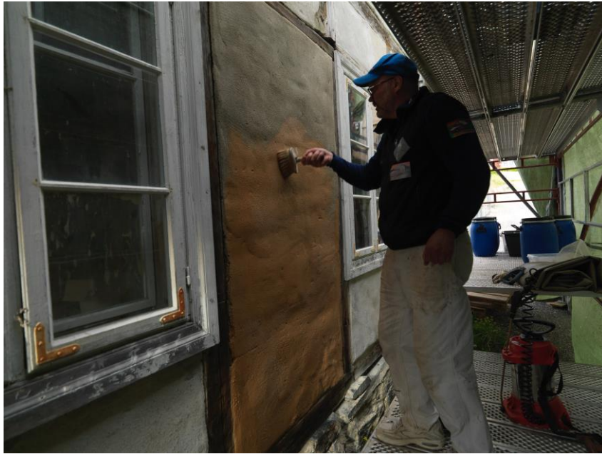
Bildene over viser stålbørsting og oppmaling av felt nr. 4
