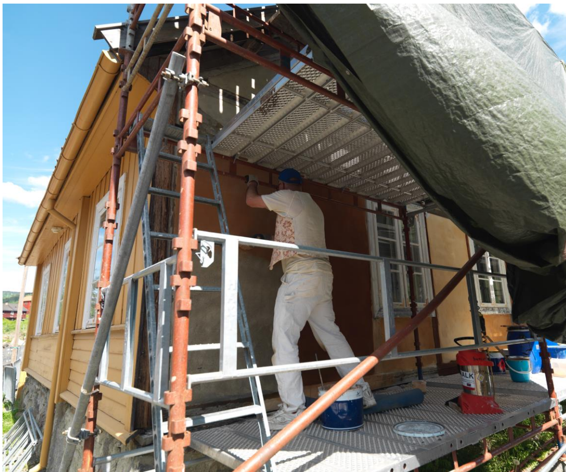
Bildet viser hvordan presenningen ble brukt som skjerming mot solens sterke varmepåvirkning.
