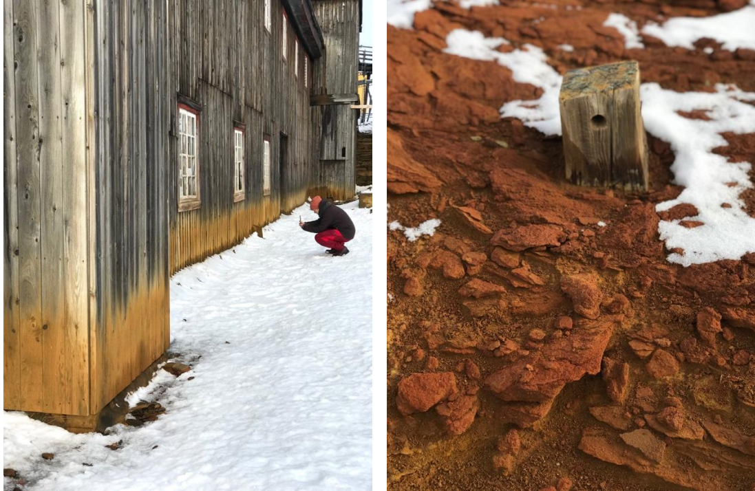
Materialeregistrering på Nedre Storwartz, der er en fredet del af Verdensarven.
