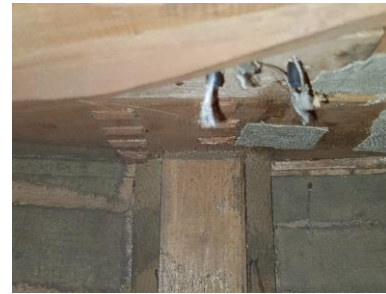
Detalj av reparasjonen på den nedre klossen.
