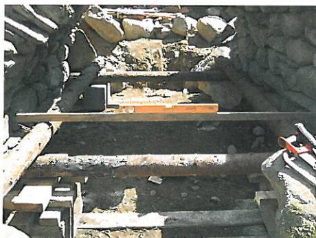
Legging av grunnramme
