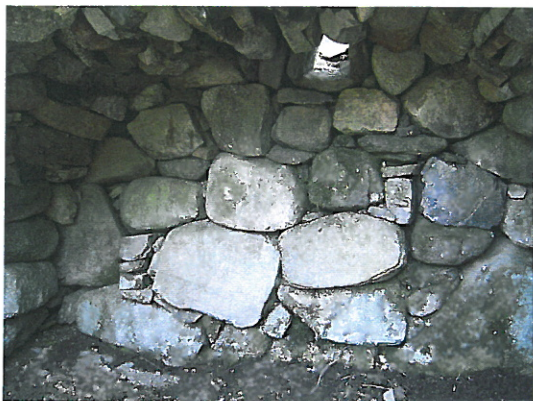
Foto : Endemur før istandsetting, Espen Marthinsen, NHU 2006
