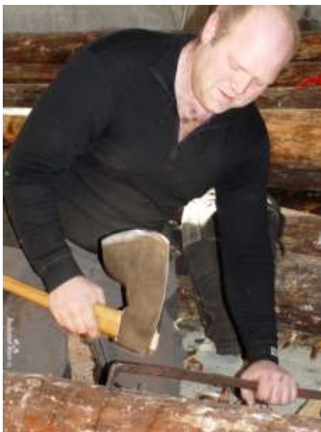
Figur 36 Tømrer som bruker øks på foreskrevne måte.
