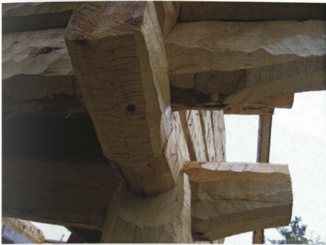
Pynteprofiler på stokkender, hugd med gleppøks.
