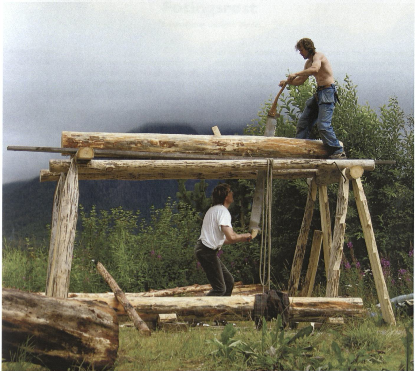
Håndsag skjæring av skråband. Thomas Aslaksby øverst på sagstillingen.
