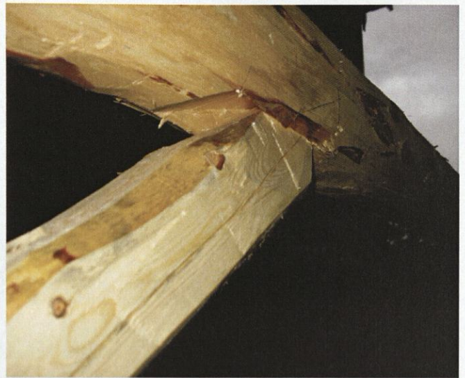
Innfelling av vindfelle i mønstong.
