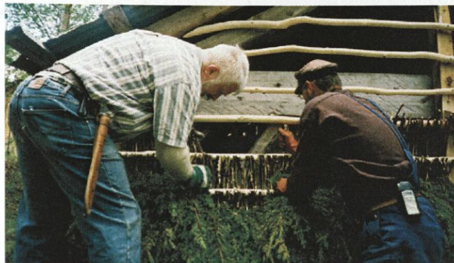
Brakekledning uten fyll. Foto: Lars Longva
