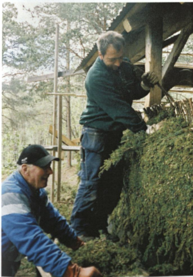
Brakekledning med fyll. Foto: Lars Longva
